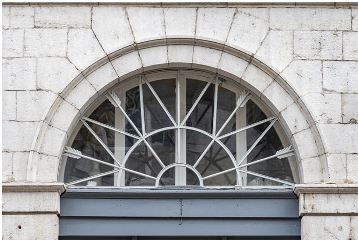
Détail des arcades en plein-cintre des grandes baies (niveau de l'entresol).
