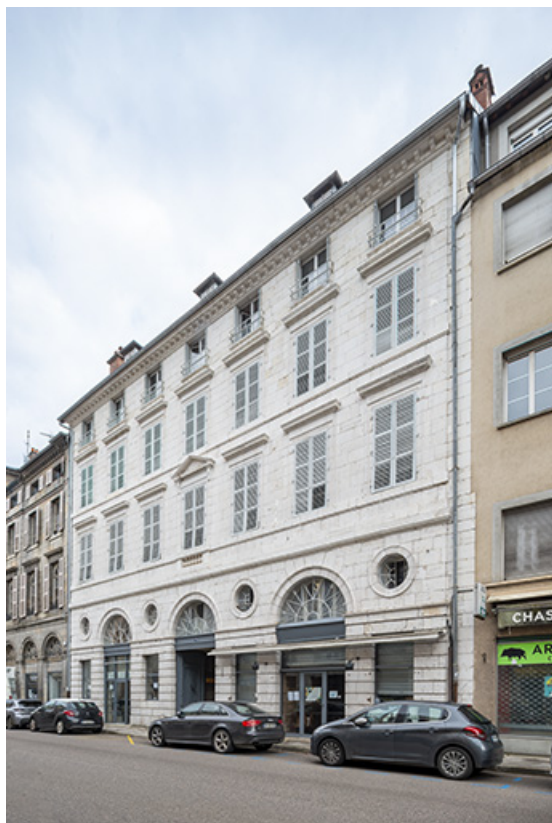
Façade antérieure vue de trois quarts droite.
