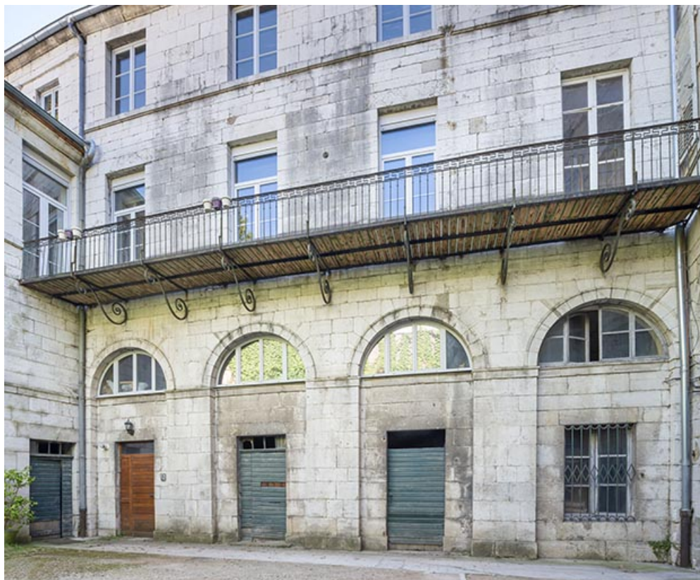
Façade de l'aile sud, depuis la cour.
