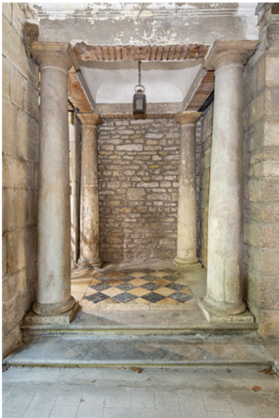
Rez-de-chaussée de l'allée cochère. Vestibule de la cage d'escalier.
