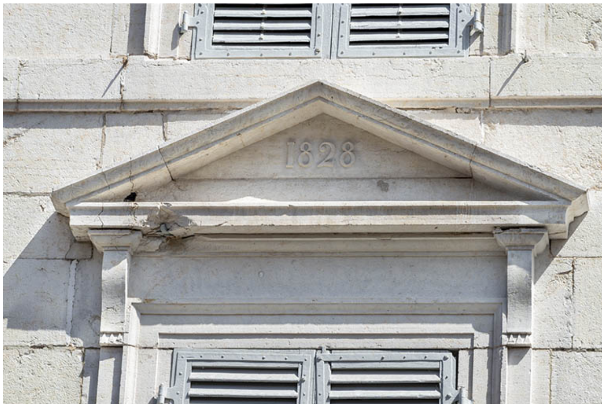
Fronton de la fenêtre centrale du premier étage.
