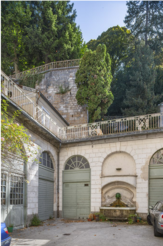
Vue d'ensemble depuis l'entrée de la cour.
