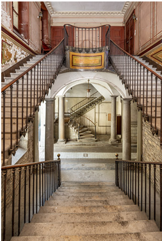
Escalier d'accès à l'étage noble. Vue axiale depuis le premier palier. 39, Salins-les-Bains, 73 rue de la République
