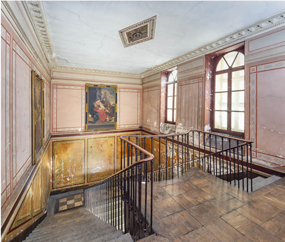
La cage d'escalier vue depuis le premier étage.
