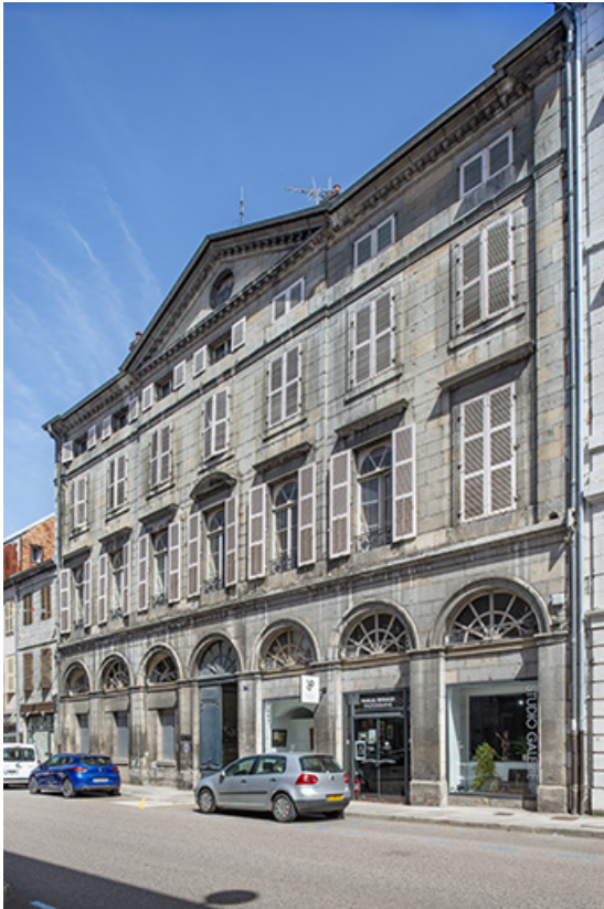
Facade antérieure vue de trois quarts droite.
