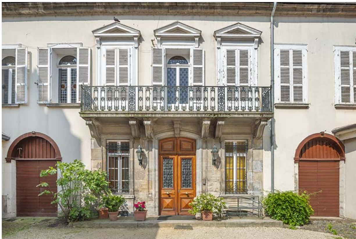
Façade est. Détail de la partie centrale.
