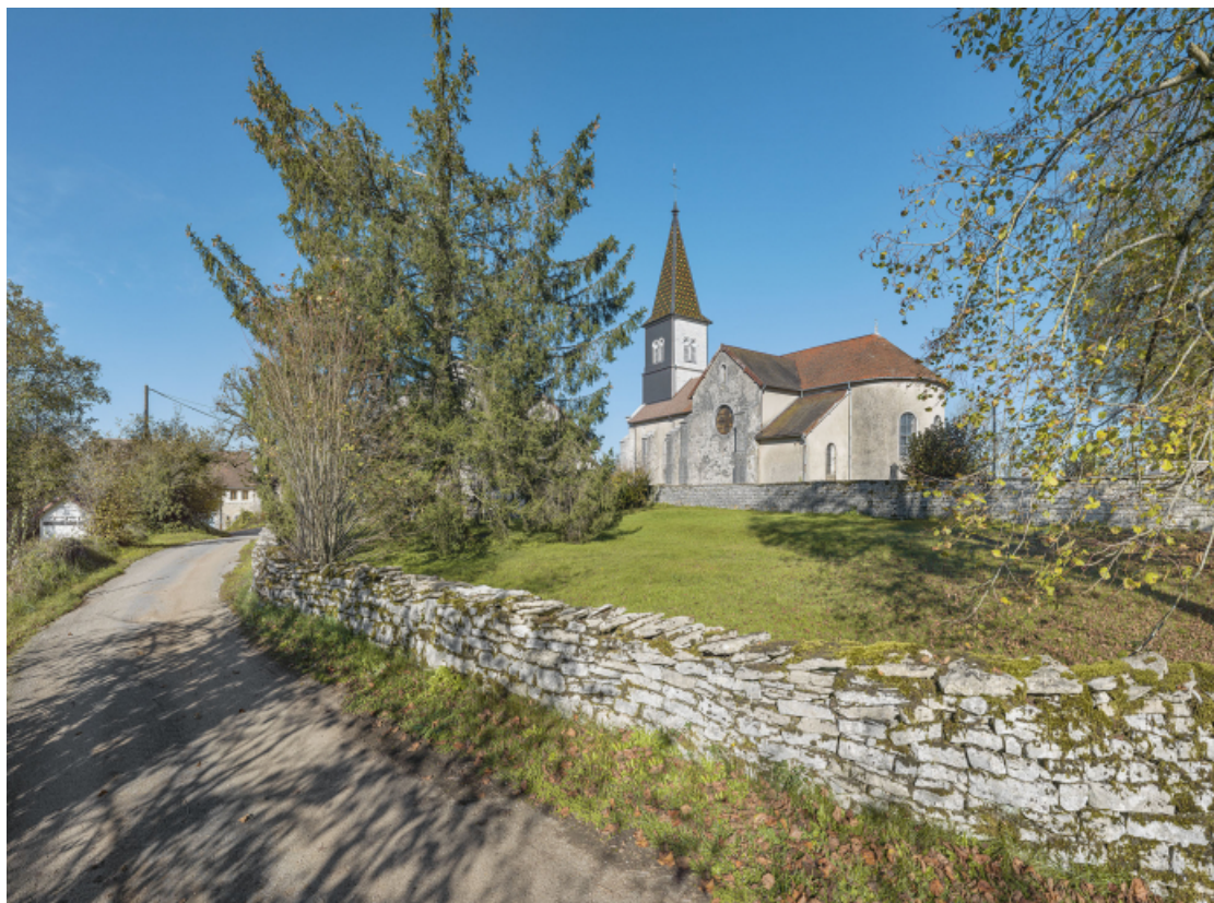
Vue d'ensemble : élévation sud et chevet.
