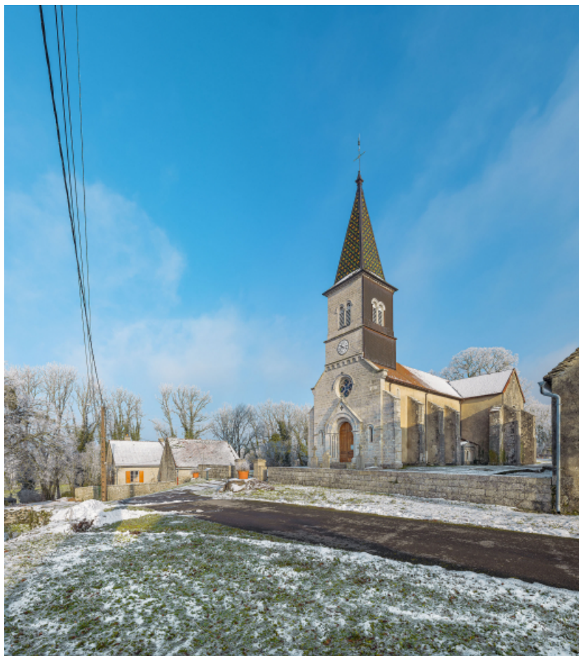
Vue d'ensemble de l'église, dans son environnement.
