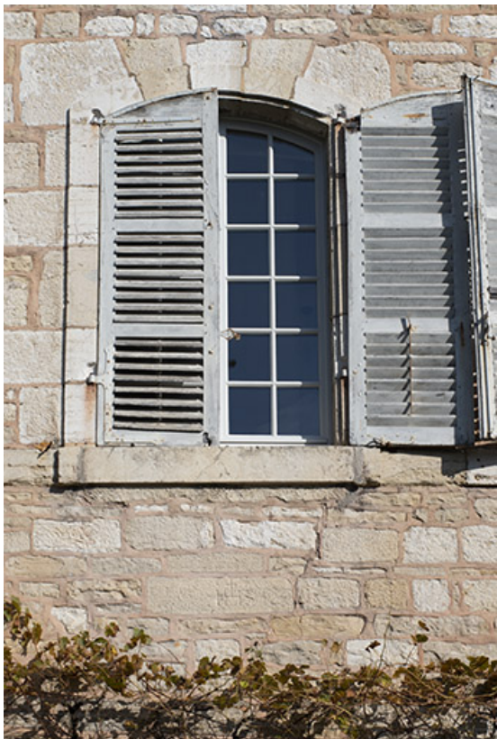
Fenêtre du rez-de-chaussée (façade ouest).
