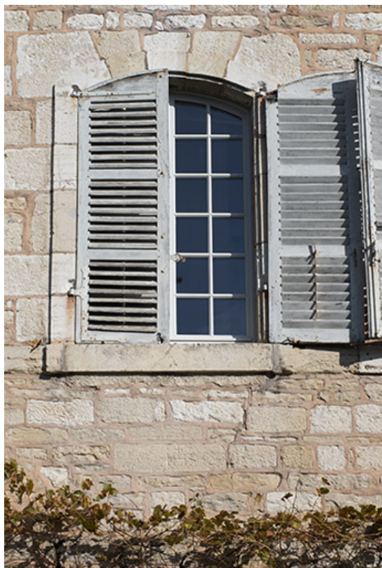
Fenêtre du rez-de-chaussée (façade ouest).
