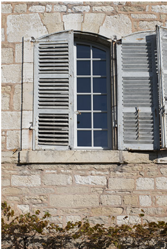
Fenêtre du rez-de-chaussée (façade ouest).
