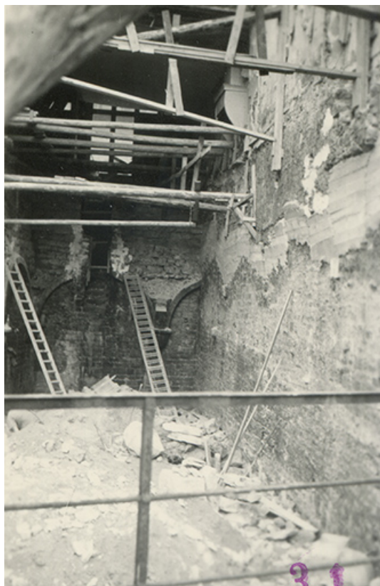
Vue de la cave pendant les travaux de démolition, s.d. [1958].
