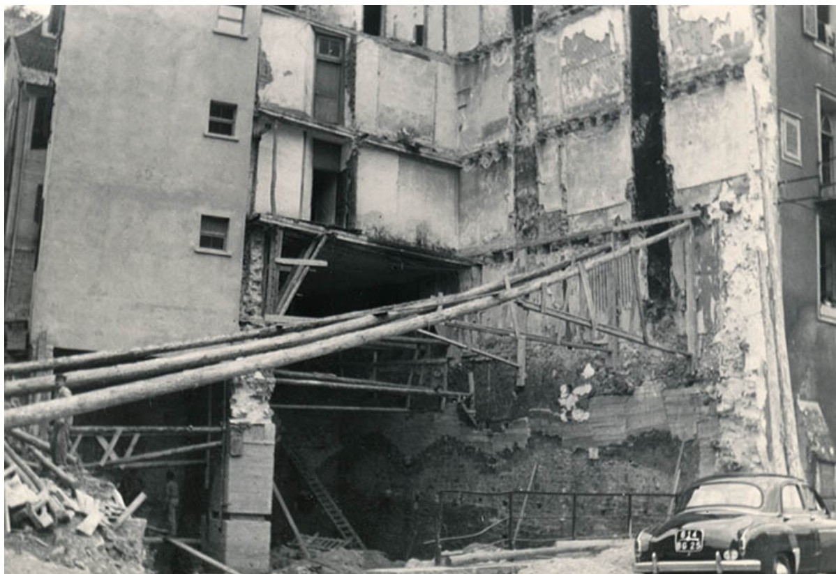
Etresillons épaulant l'immeuble mitoyen (n°7).
