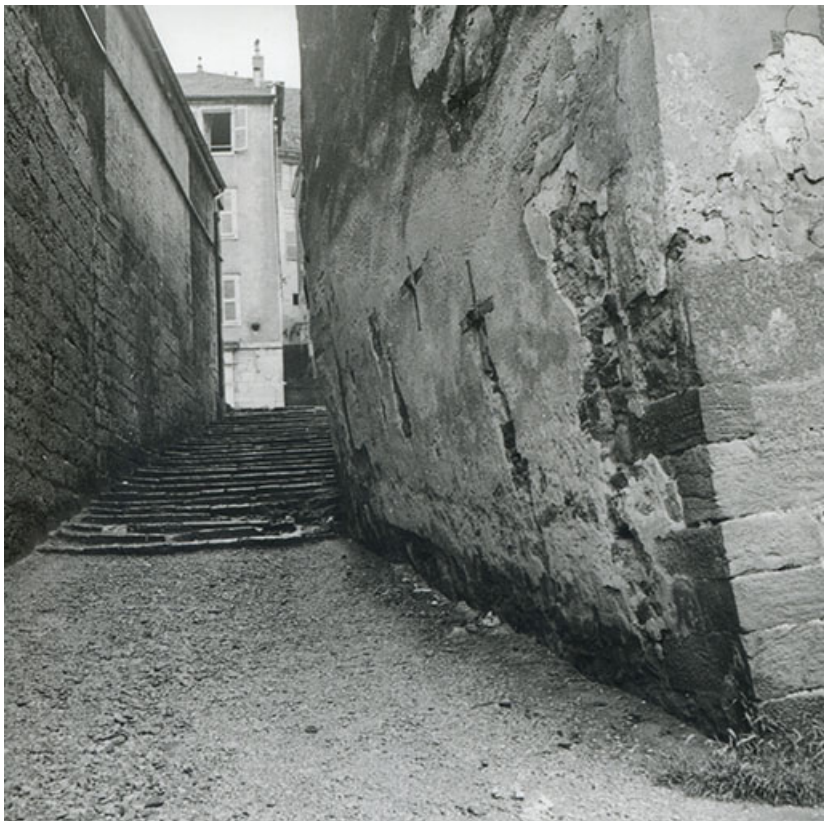
Passage de l'escalier de Falletans (ou d'Arion), s.d. [années 1950]. 39, Salins-les-Bains, 6 rue Gambetta
