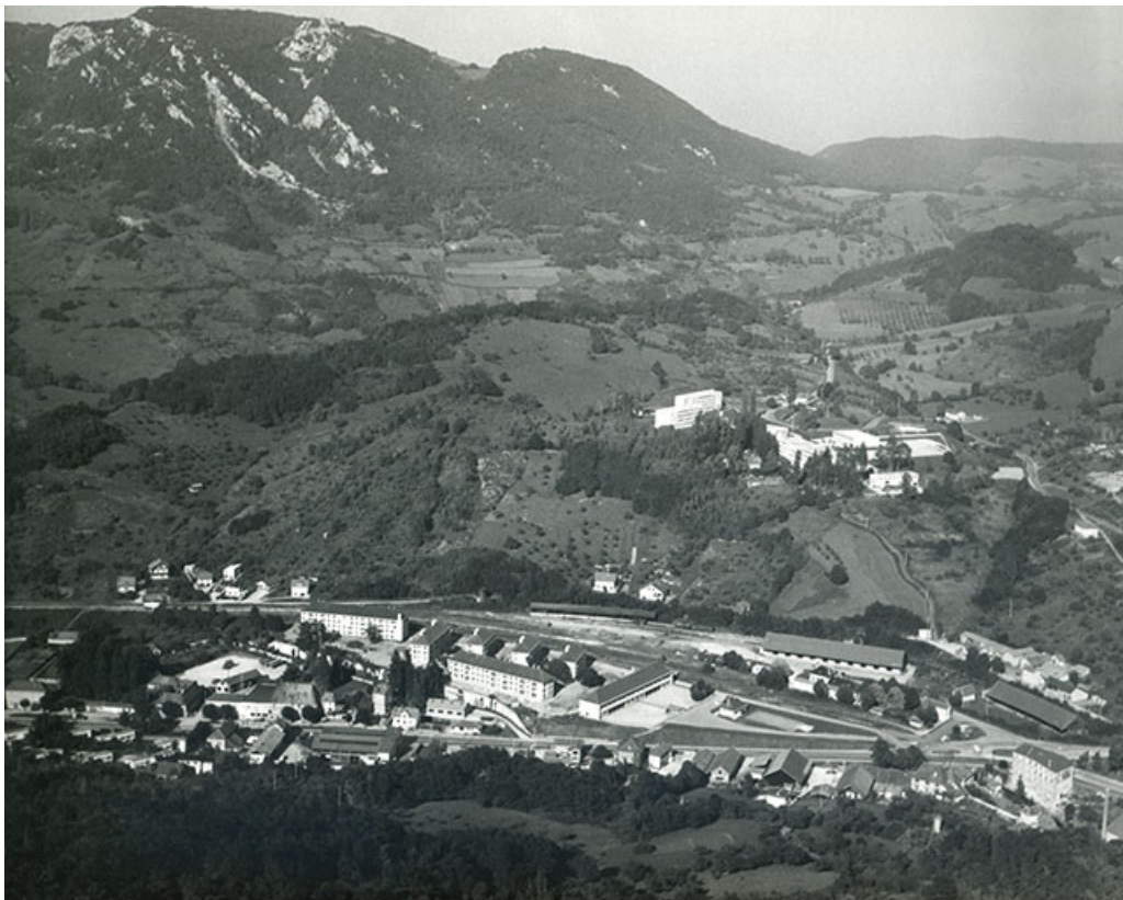
Vue plongeante depuis l'ouest, s.d. [vers 1975].
