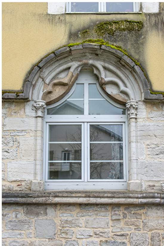
Façade nord. Détail de la fenêtre droite.
