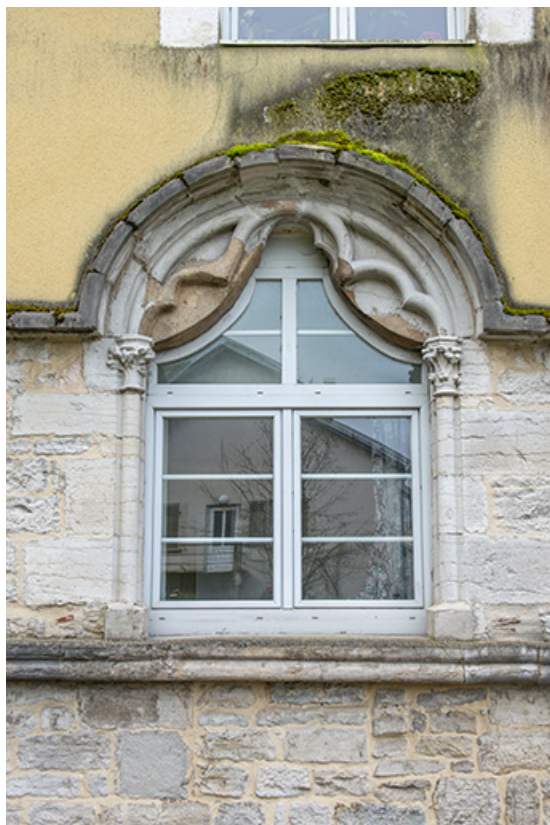
Façade nord. Détail de la fenêtre droite.
