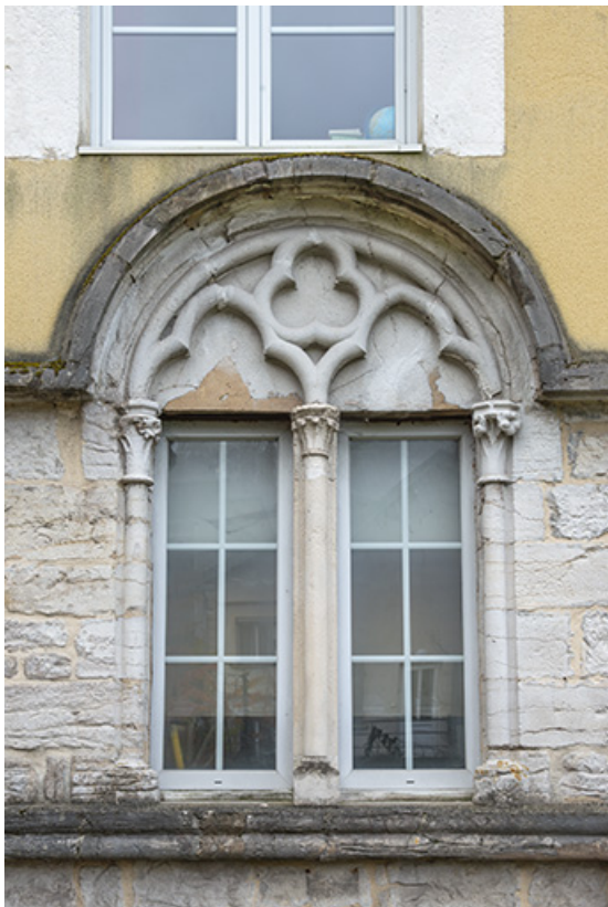
Façade nord. Détail de la fenêtre gauche.
