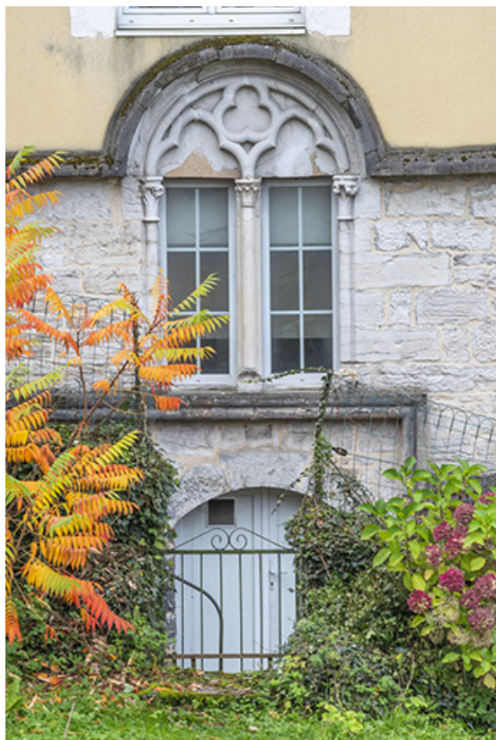
Façade nord. Fenêtre en plein-cintre, à remplage et colonnettes.
