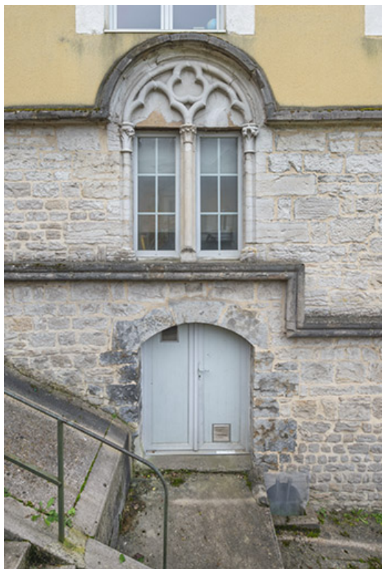
Façade nord. Alignement de la porte et de la fenêtre cintrée.
