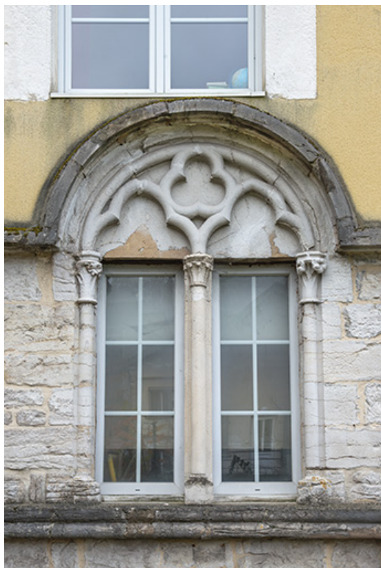
Façade nord. Détail de la fenêtre gauche.
