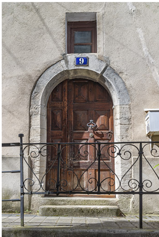
Porte piétonne donnant sur la rue du Corneux.
