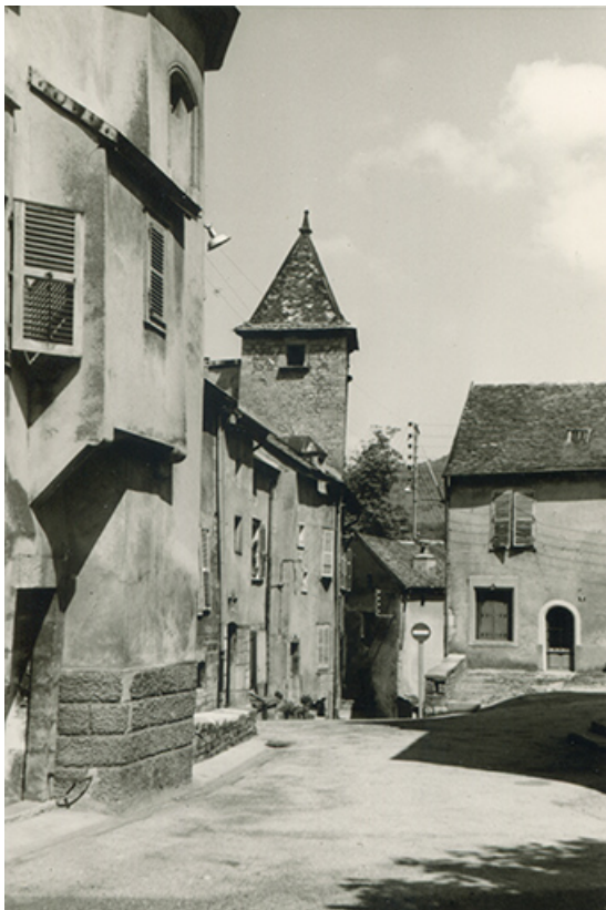
Vue d'ensemble depuis la place de l'église, s.d. [milieu 20e siècle]. 39, Salins-les-Bains, 9 rue du Corneux
