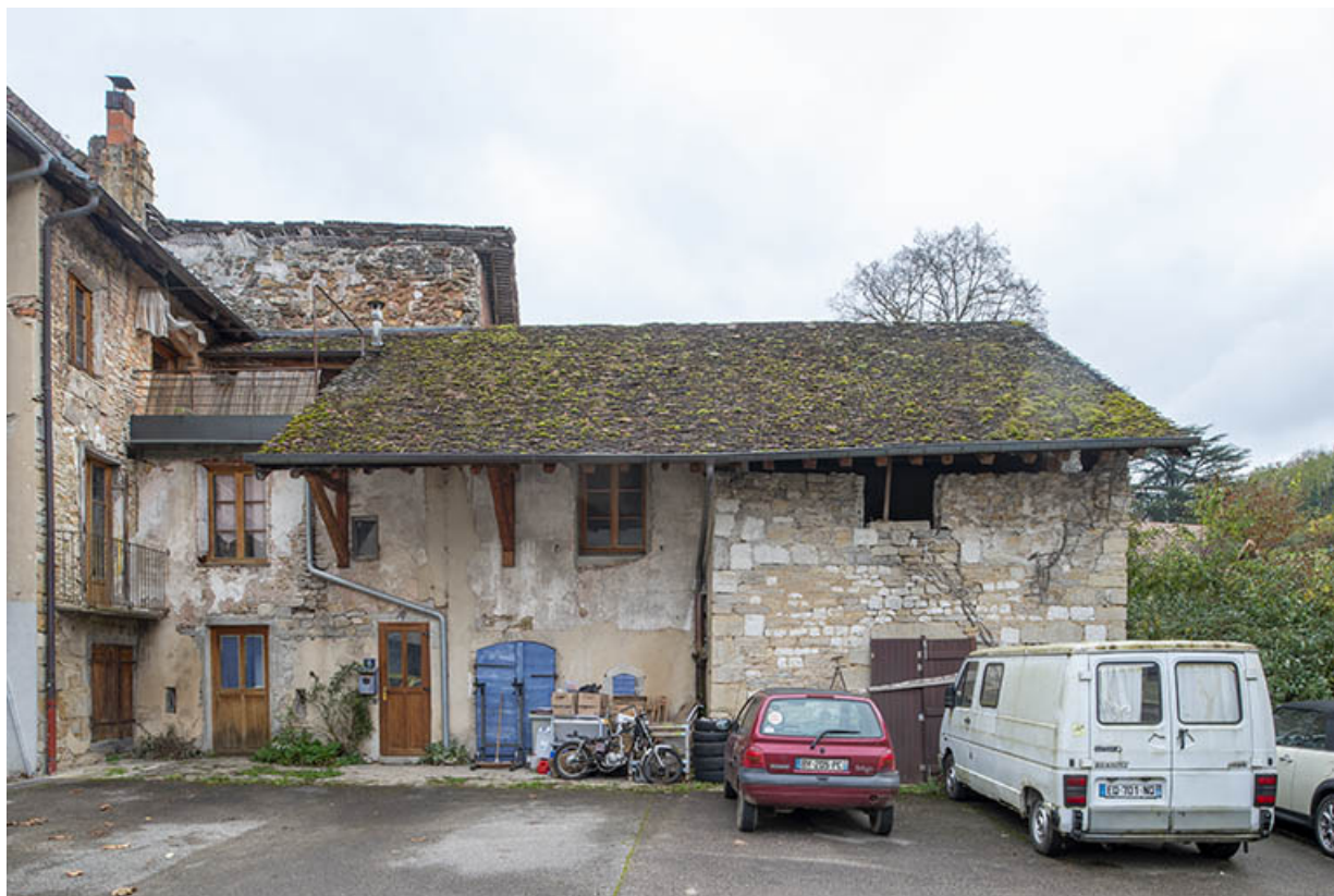
Partie sud de la maison et atelier sur cour.
