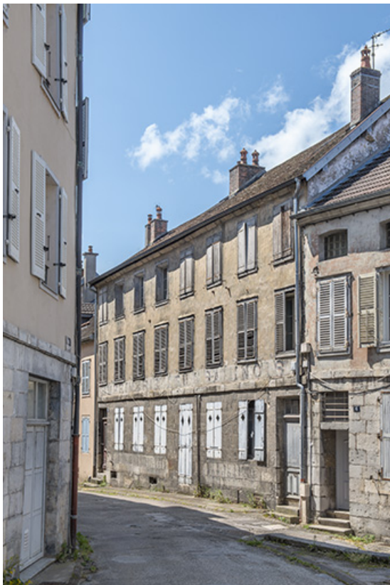
Façade postérieure (rue d'Orgemont) vue de trois quarts droite.
