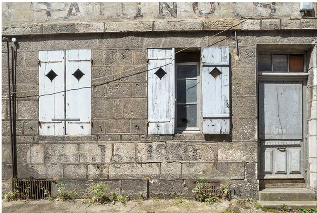
Façade rue d'Orgemont. Rez-de-chaussée des travées nord.
