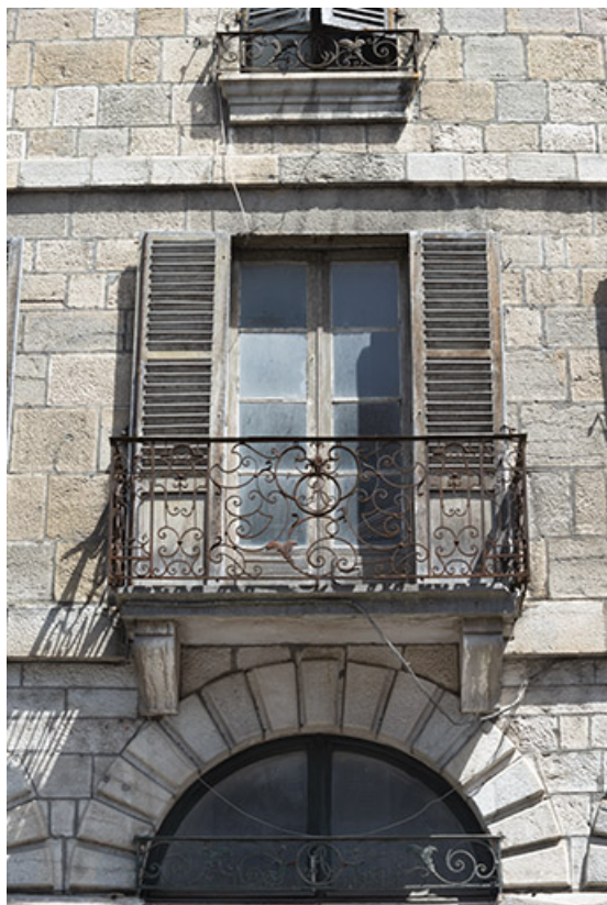
Façade antérieure. Partie inférieure de la travée centrale.
