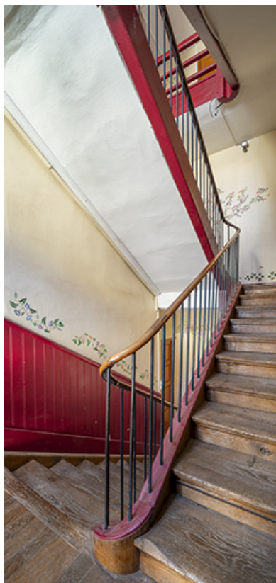
Escalier donnant accès aux appartements et à la rue Charles David.
