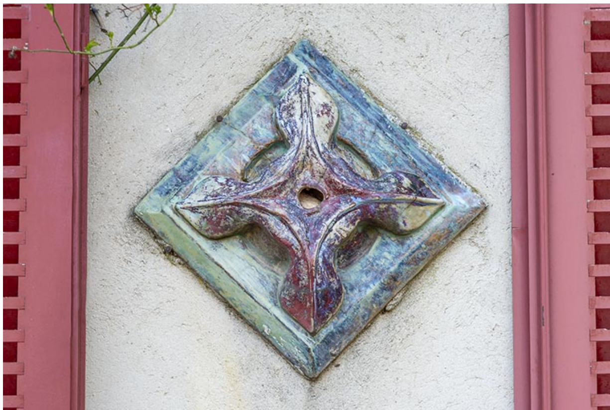
Façade ouest du logement. Détail d'un caboçon.
