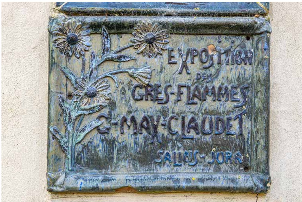
Façade nord : cartouche en grès flammé.
