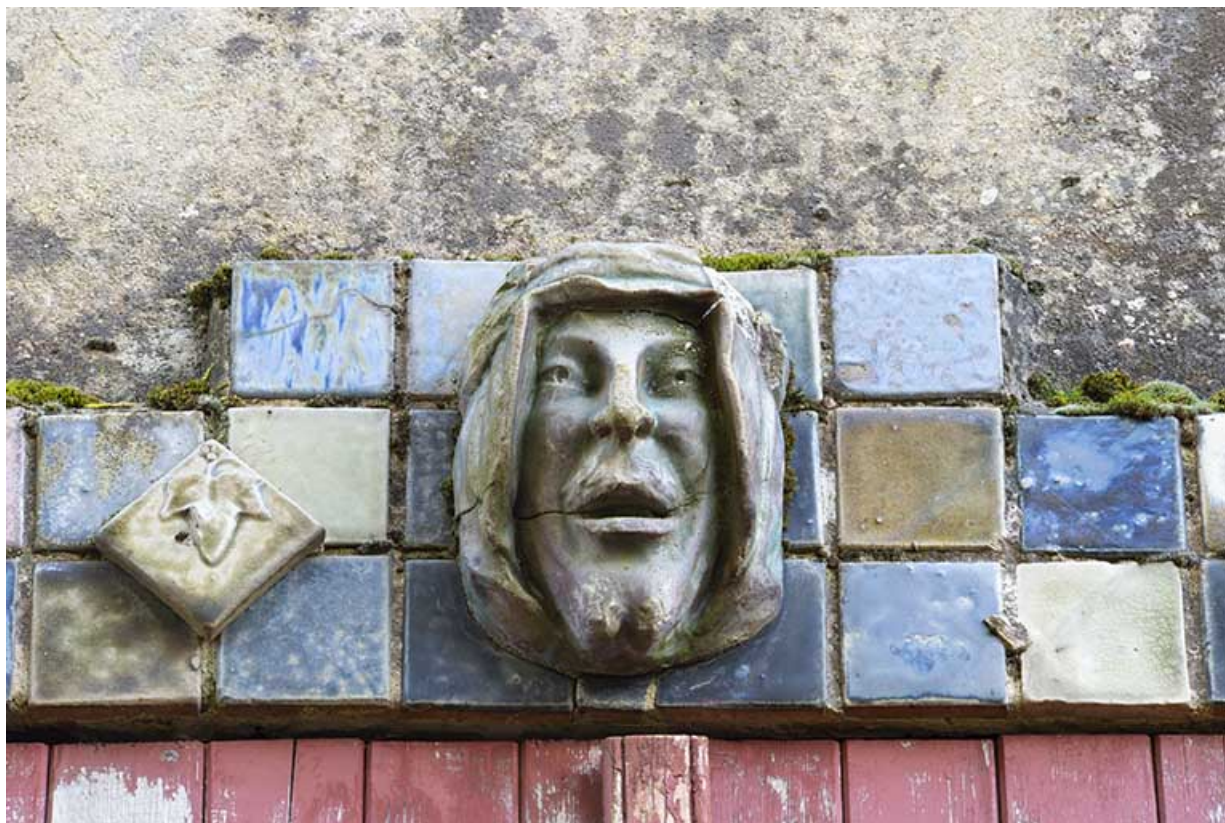
Façade ouest. Détail d'un mascarón sur un linteau de fenêtre.
