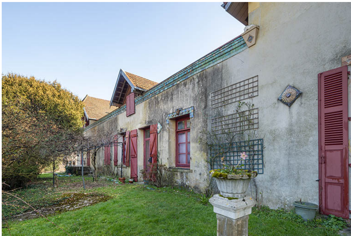
Élévation des façades ouest. Vue de trois quarts droite.
