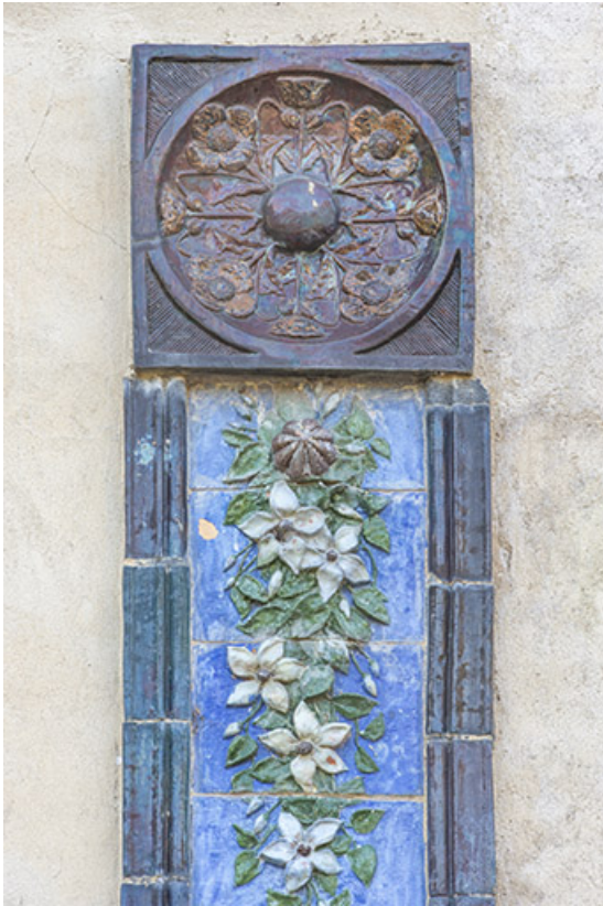
Façade nord. Extrémité supérieure du décor. 39, Salins-les-Bains, 3 route de Champagnole
