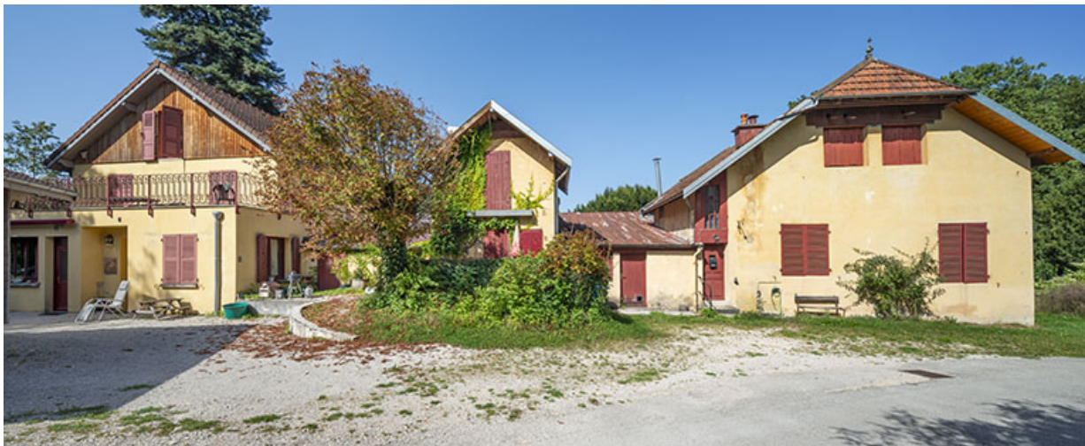
Façades est depuis le chemin de Prailles. 39, Salins-les-Bains, 3 route de Champagnole
