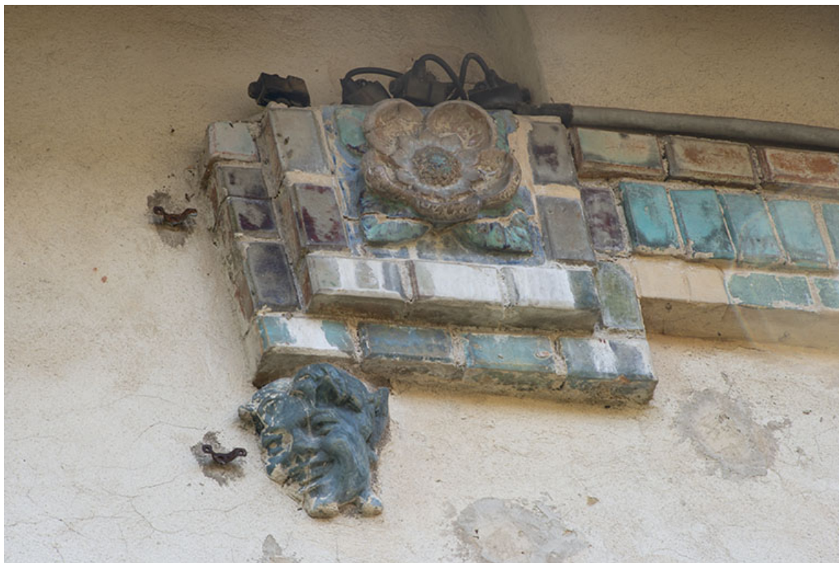
Façade nord. Extrémité de la frise.
