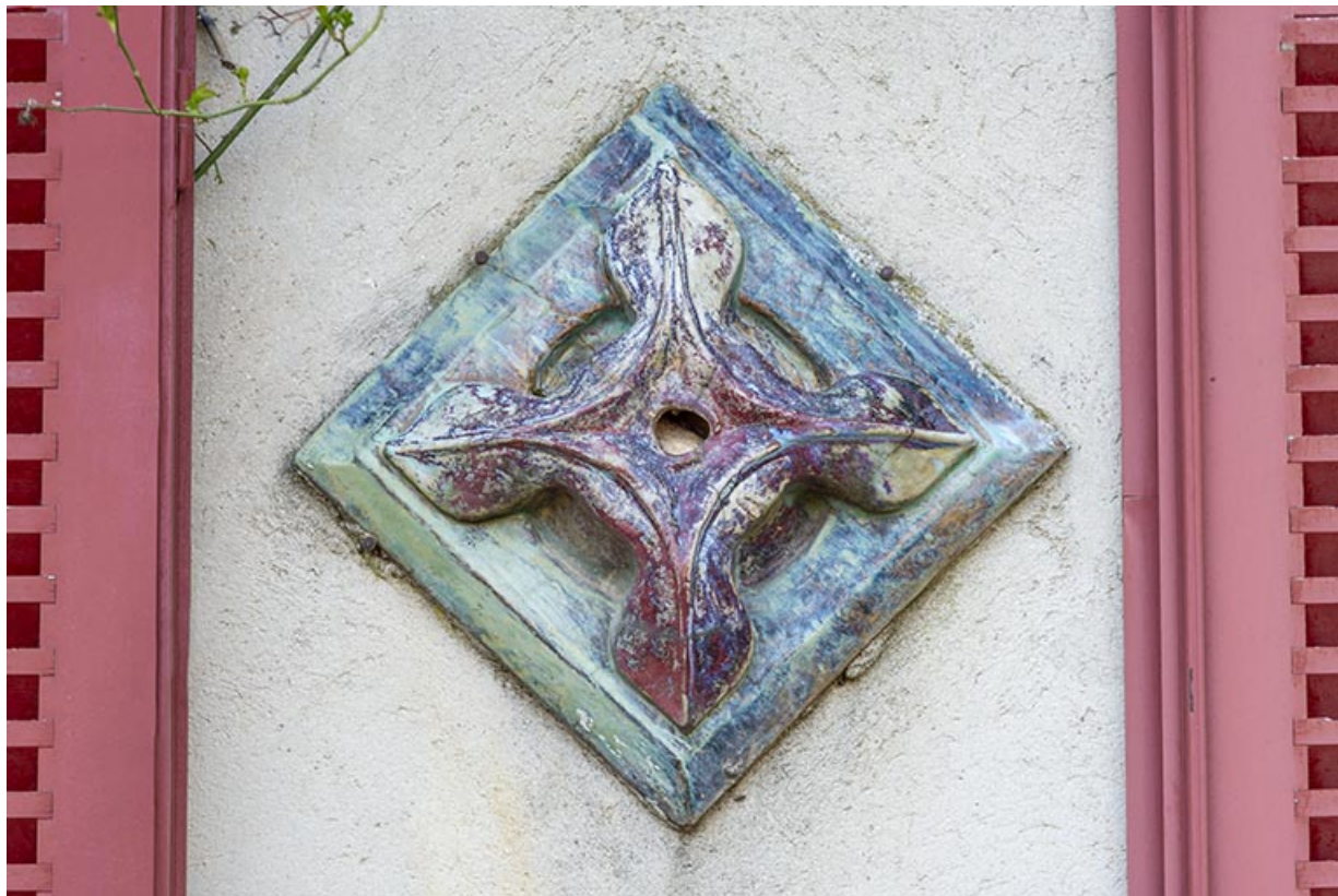
Façade ouest du logement. Détail d'un cabocho.
