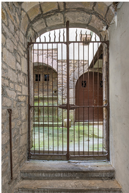
Grille située entre le couloir et la cour.
