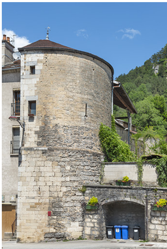
Vue rapprochée depuis l'ouest.
