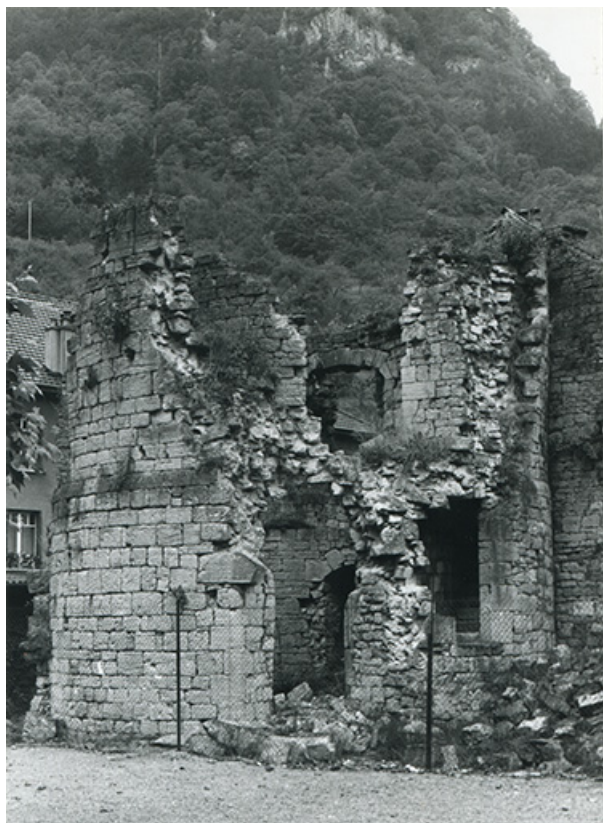
Vue d'ensemble depuis l'est. Etat en 1983.
