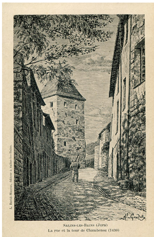
Salins-les-Bains (Jura). La rue et la tour de Chambenoz (1430), carte postale, s.d. [avant 1902]. 39, Salins-les-Bains rue des Chambenoz
