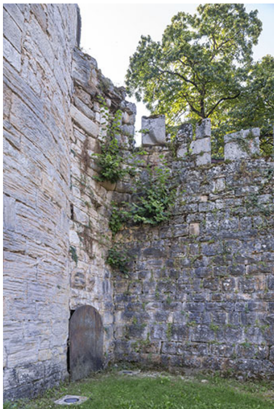
Jonction entre la tour et la courtine nord.
