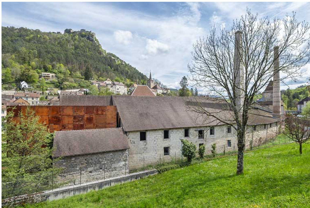
Façades ouest des bâtiments de production.
