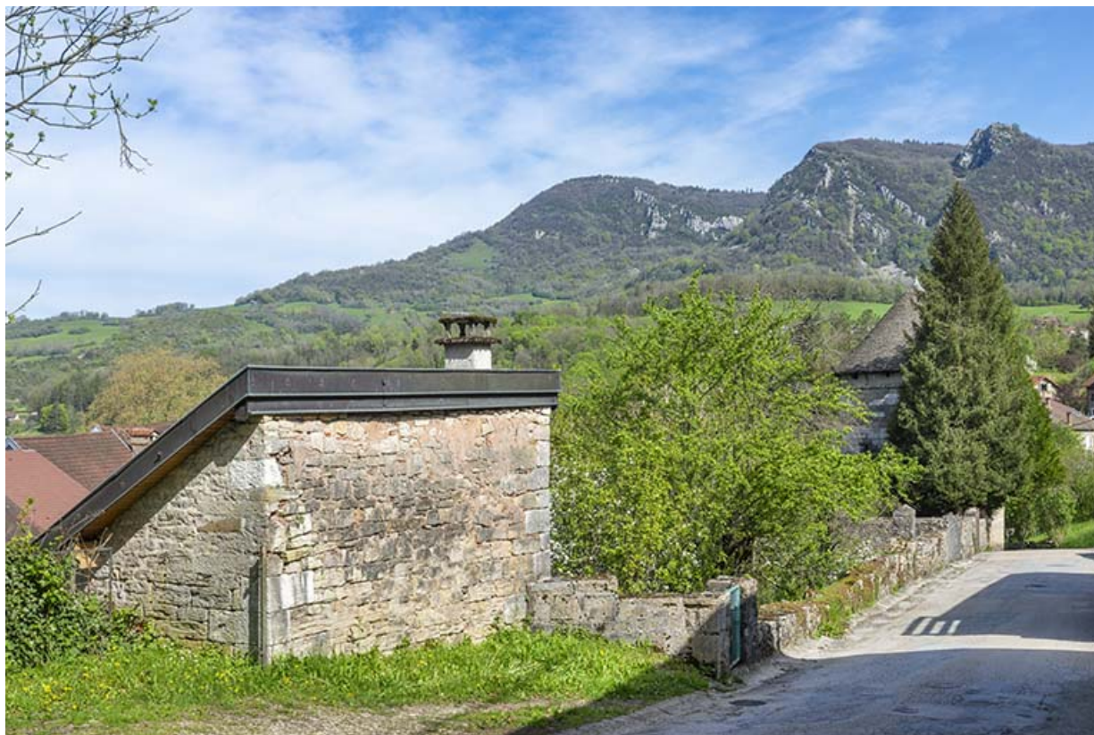
Chemin de la Tour ronde. Vestiges de la tour Galzot et partie sud du rempart. 39, Salins-les-Bains
