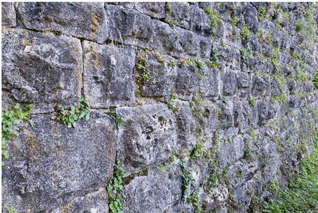
Détail du bossage de la courtine nord, près de la tour d'Andelot. 39, Salins-les-Bains
