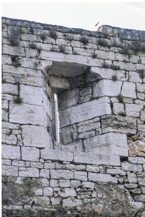
Embrasure de meurtrière dans le rempart conservé au nord du pont Saint-Nicolas, 2011. 39, Salins-les-Bains
