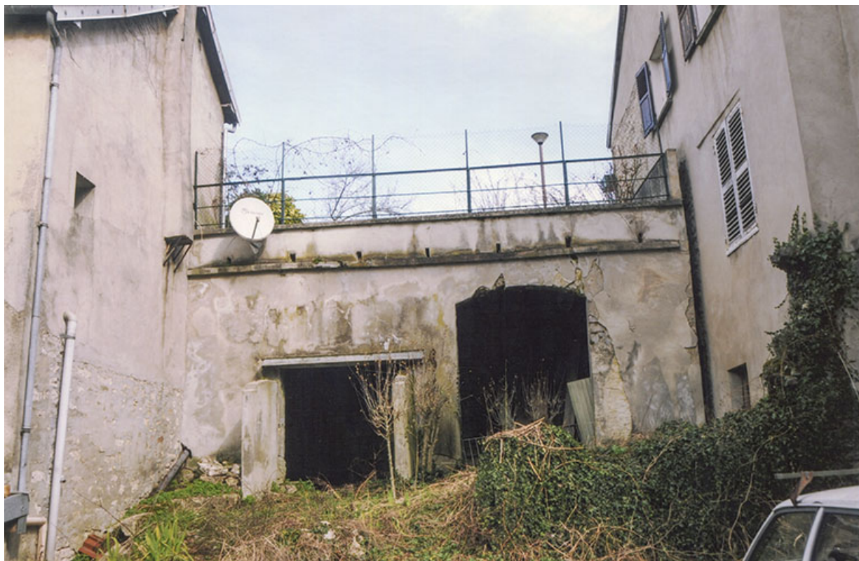
Constructions modernes adossées au mur de courtine nord, rue des Corneux, 2011. 39, Salins-les-Bains
