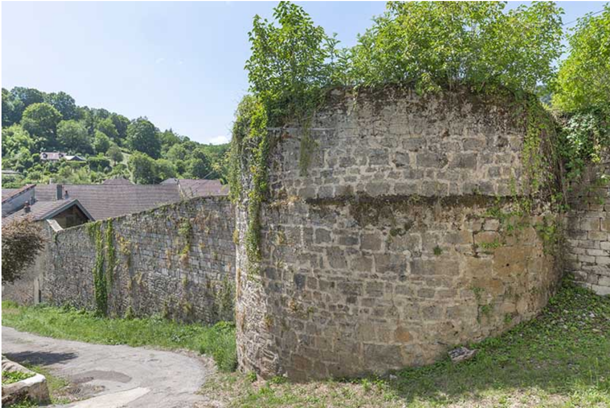
Rempart sud et tour Rouge. 39, Salins-les-Bains
