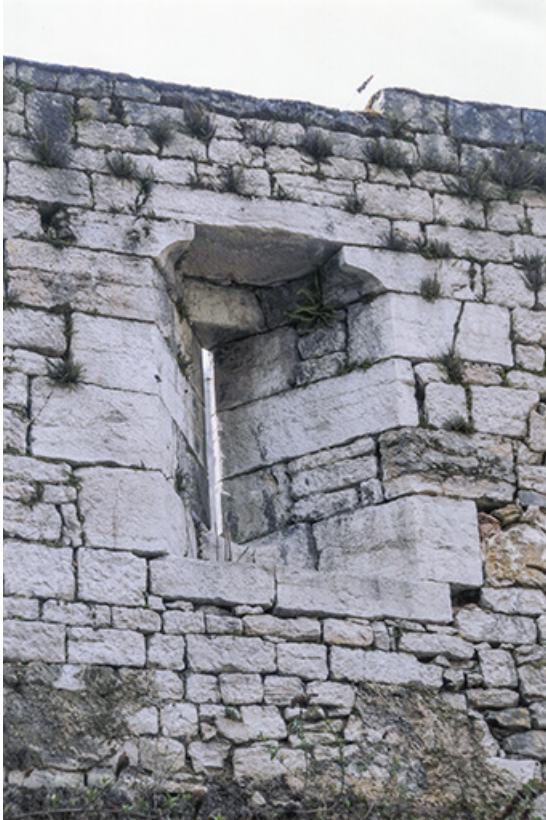
Embrasure de meurtrière dans le rempart conservé au nord du pont Saint-Nicolas, 2011. 39, Salins-les-Bains
