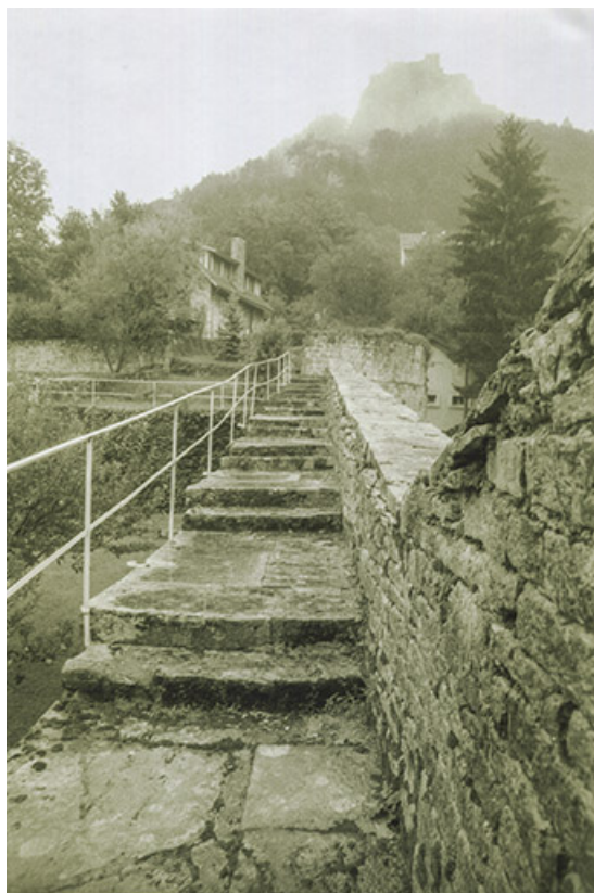
Chemin de ronde arasé longeant la courtine sud, 2011. 39, Salins-les-Bains
