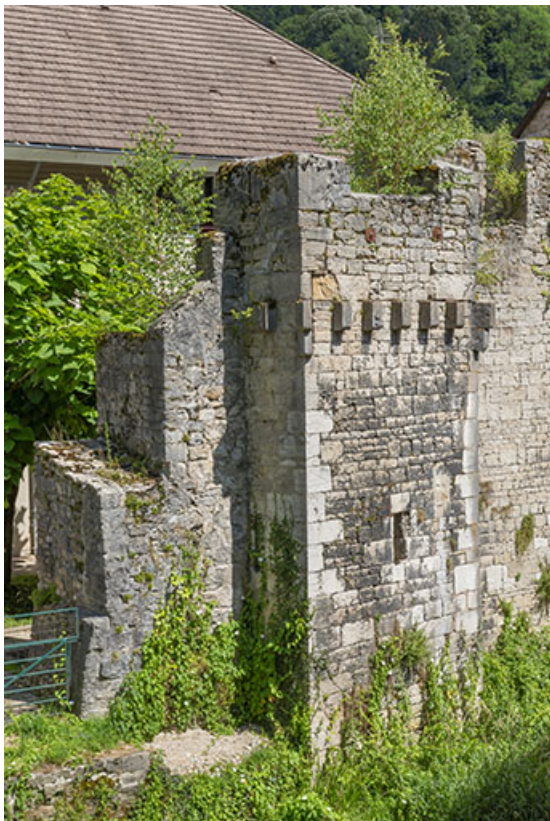
Vestiges de la tour en aval de la porte Saint-Nicolas. 39, Salins-les-Bains
