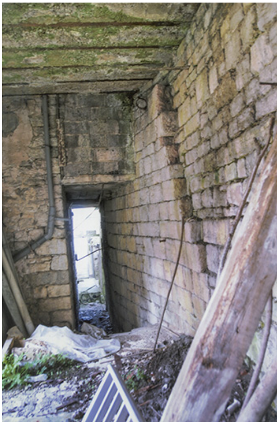
Parement de la courtine nord, rue des Corneux, 2011. 39, Salins-les-Bains
