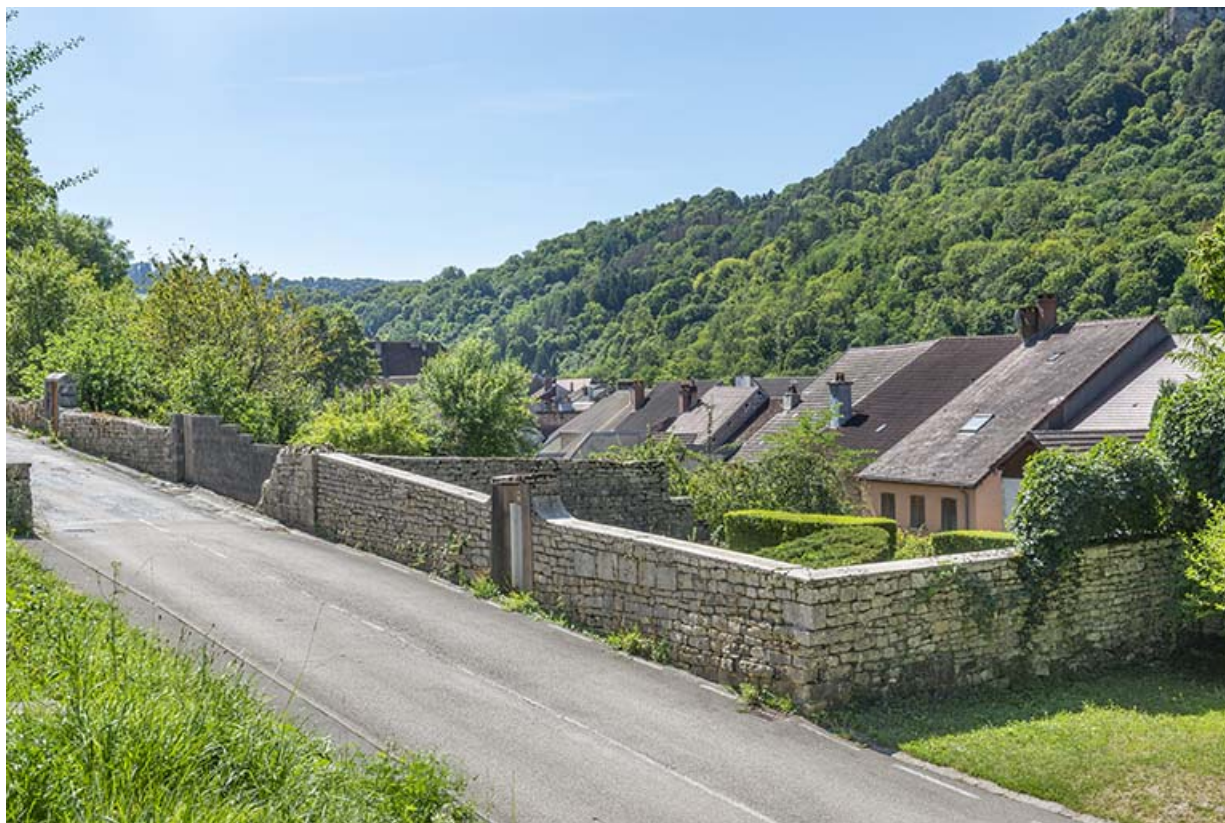
Tracé du mur d'enceinte est longeant le bas du chemin de la Tour ronde. 39, Salins-les-Bains
