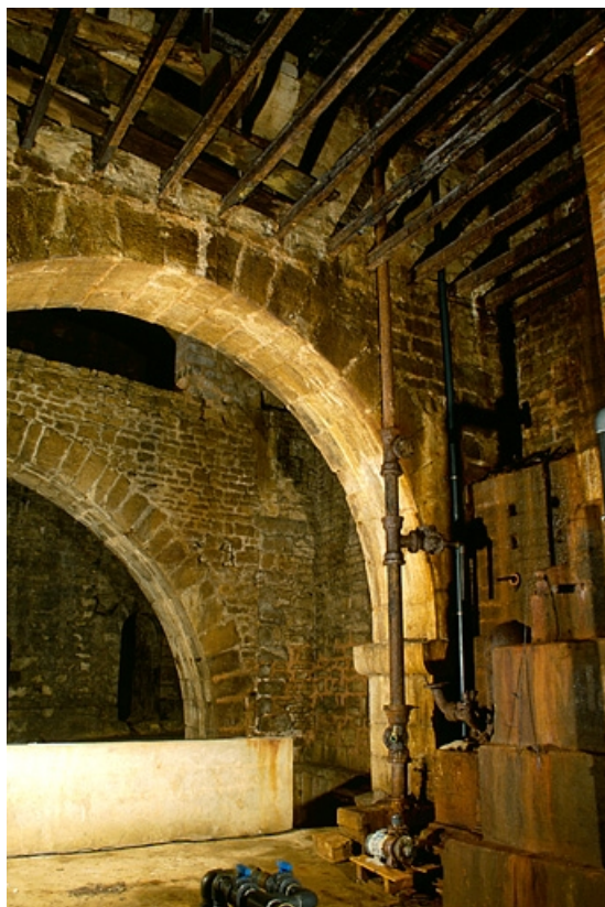
Arcs-diaphragmes sud du puits à Muire. Les 2 baies cintrées visibles dans le mur du fond donnaient accès à une ancienne source. 39, Salins-les-Bains, 2 place des Alliés et de la Résistance
