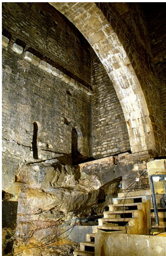
Mur sud du puits à Muire depuis le niveau inférieur. La principale source salée jaillit à gauche de l'escalier. 39, Salins-les-Bains, 2 place des Alliés et de la Résistance
