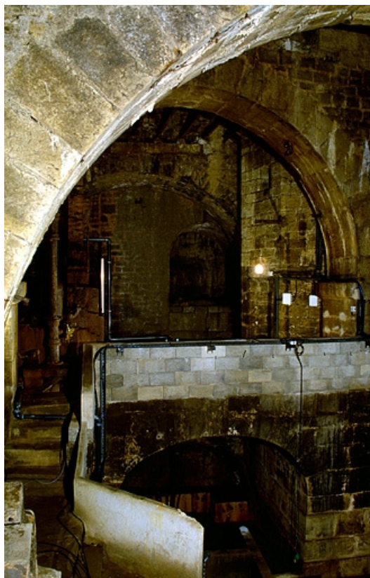
Vue d'ensemble du puits à Muire depuis l'angle sud-ouest.
