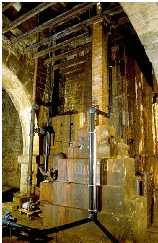
Massif de maçonnerie du puits à Muire supportant les installations de pompage. À gauche, les anciennes canalisations de remontée de l'eau salée (hors d'usage).
