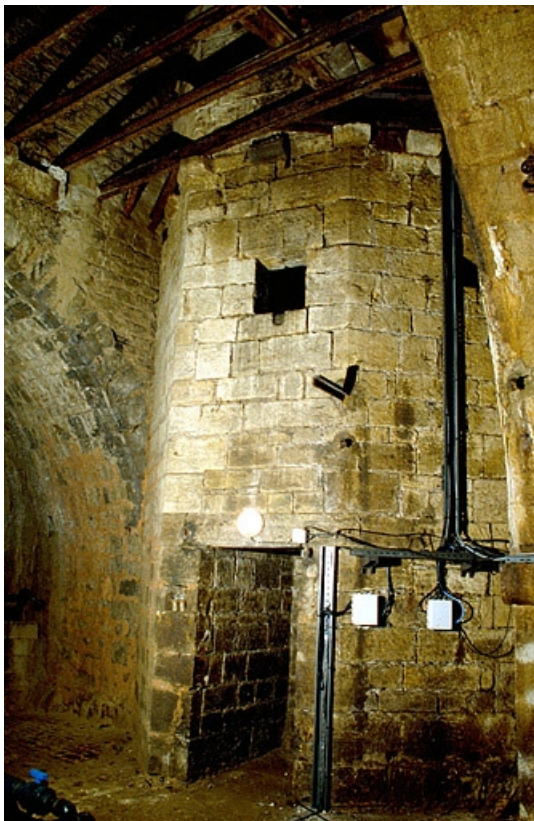
Escalier à vis débouchant au fond du puits à Muire.
