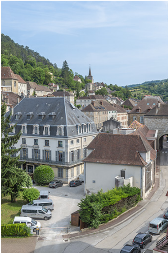
Vue plongeante sur l'hôtel des Bains et l'établissement thermal, construits à l'emplacement des bâtiments de la petite saline. 39, Salins-les-Bains, 2 place des Alliés et de la Résistance
