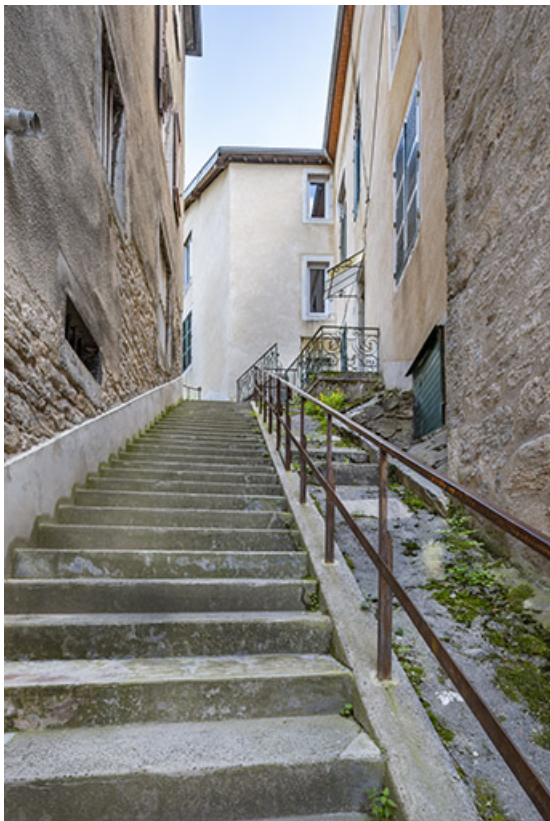
Façade nord (à droite), depuis l'escalier des Sires de Poupet.
