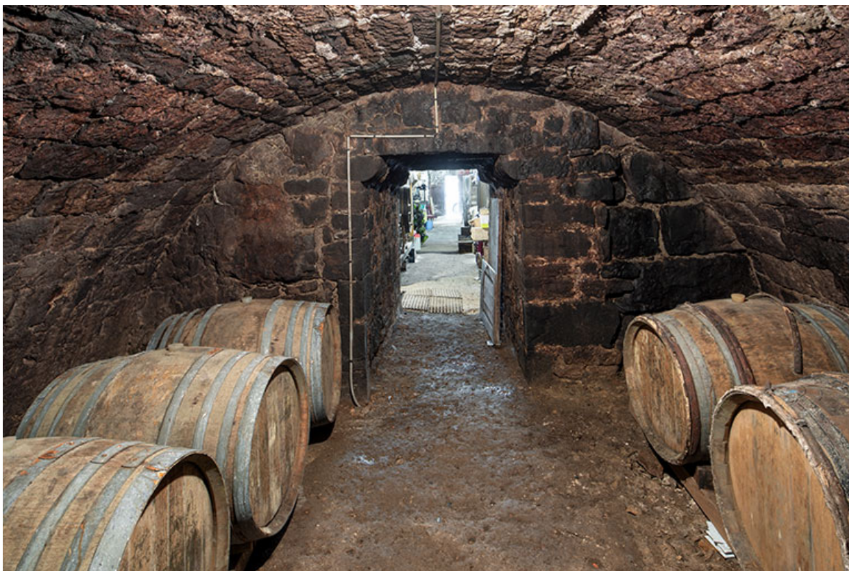
Cave du bâtiment sur rue. Pièce maçonnée à l'extrémité ouest de la travée centrale. 39, Salins-les-Bains, 13 rue de la Liberté
