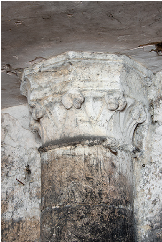
Cave du bâtiment sur rue. Chapiteau à crochets.
