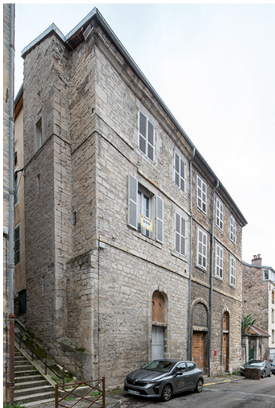
Bâtiment sur rue, vu depuis de trois quarts droite.
