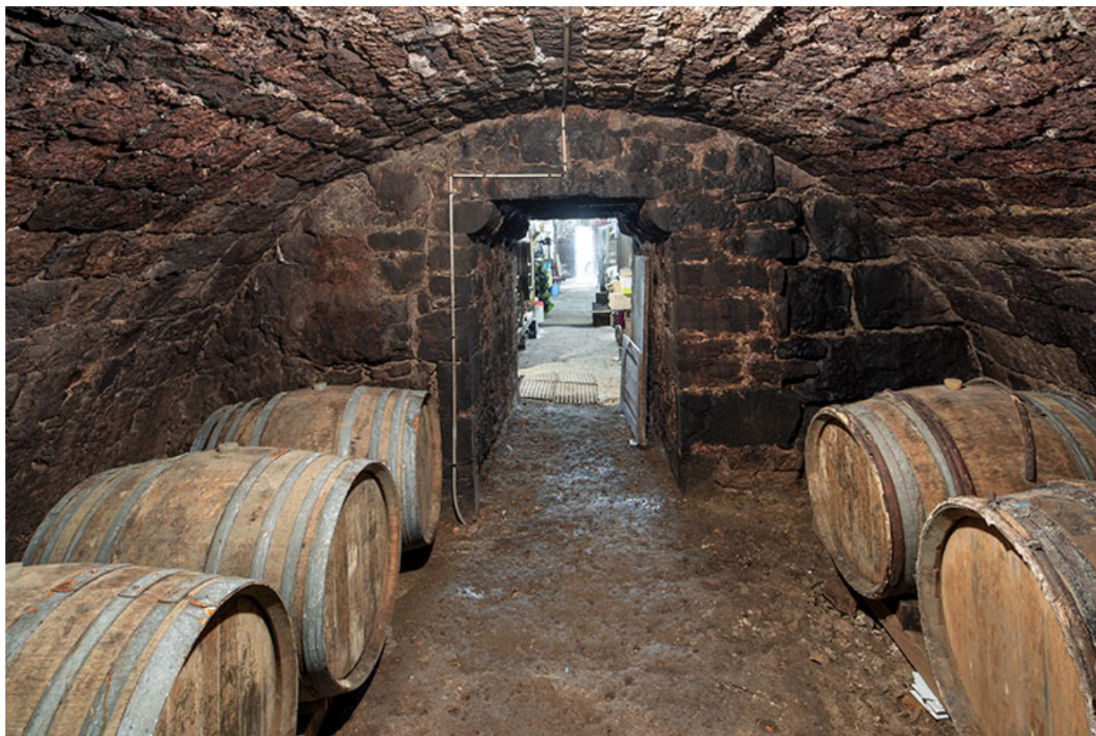
Cave du bâtiment sur rue. Pièce maçonnée à l'extrémité ouest de la travée centrale. 39, Salins-les-Bains, 13 rue de la Liberté
