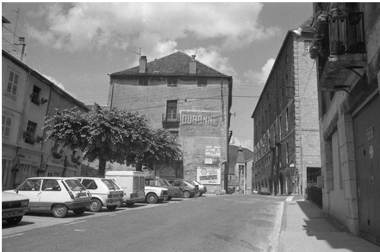
Mur pignon de l'immeuble n°27 rue de la Liberté, depuis le sud.
