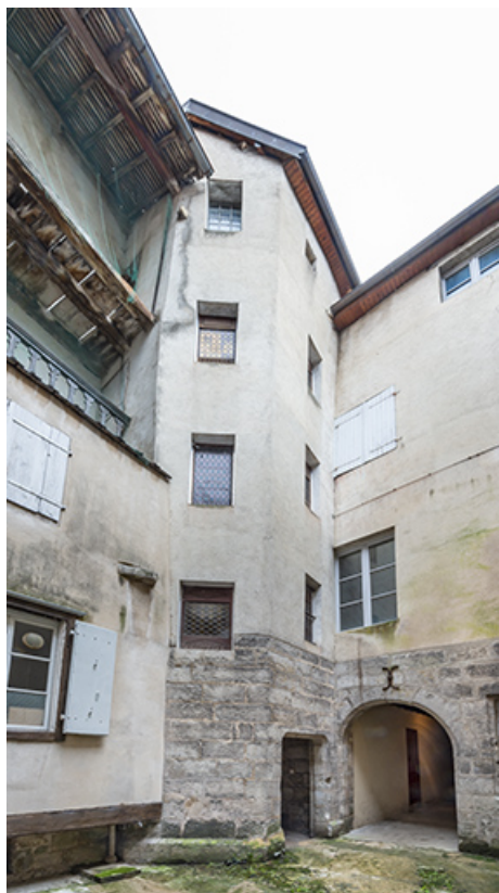
Tour d'escalier polygonale, depuis la cour. 39, Salins-les-Bains, 37 rue de la Liberté
