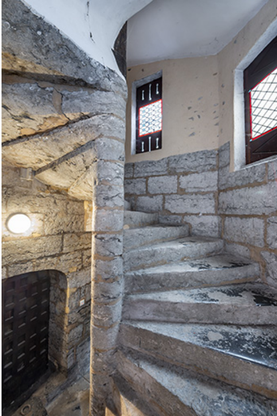
Escalier en vis : accès au premier étage.
