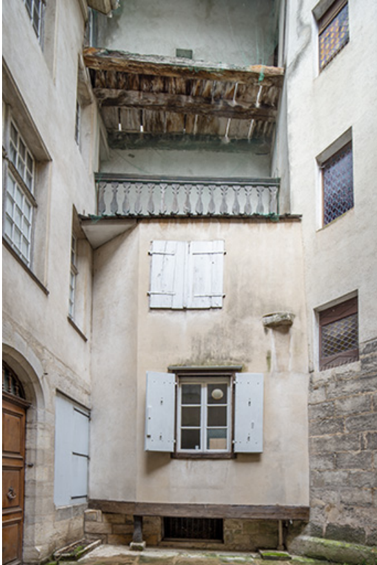
Extension nord, contre la cage d'escalier en vis.
