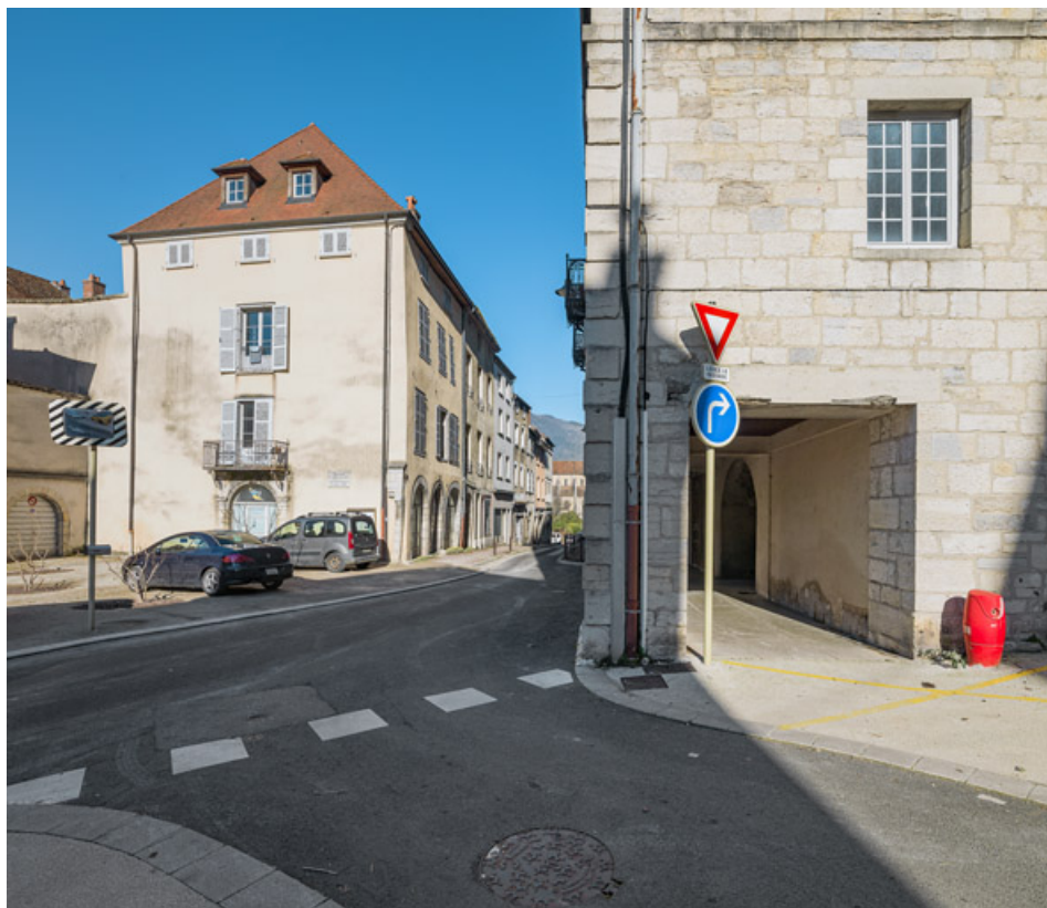
Immeuble sur rue. Vue d'ensemble depuis le bas de la rue Charles Magnien. 39, Salins-les-Bains, 37 rue de la Liberté
