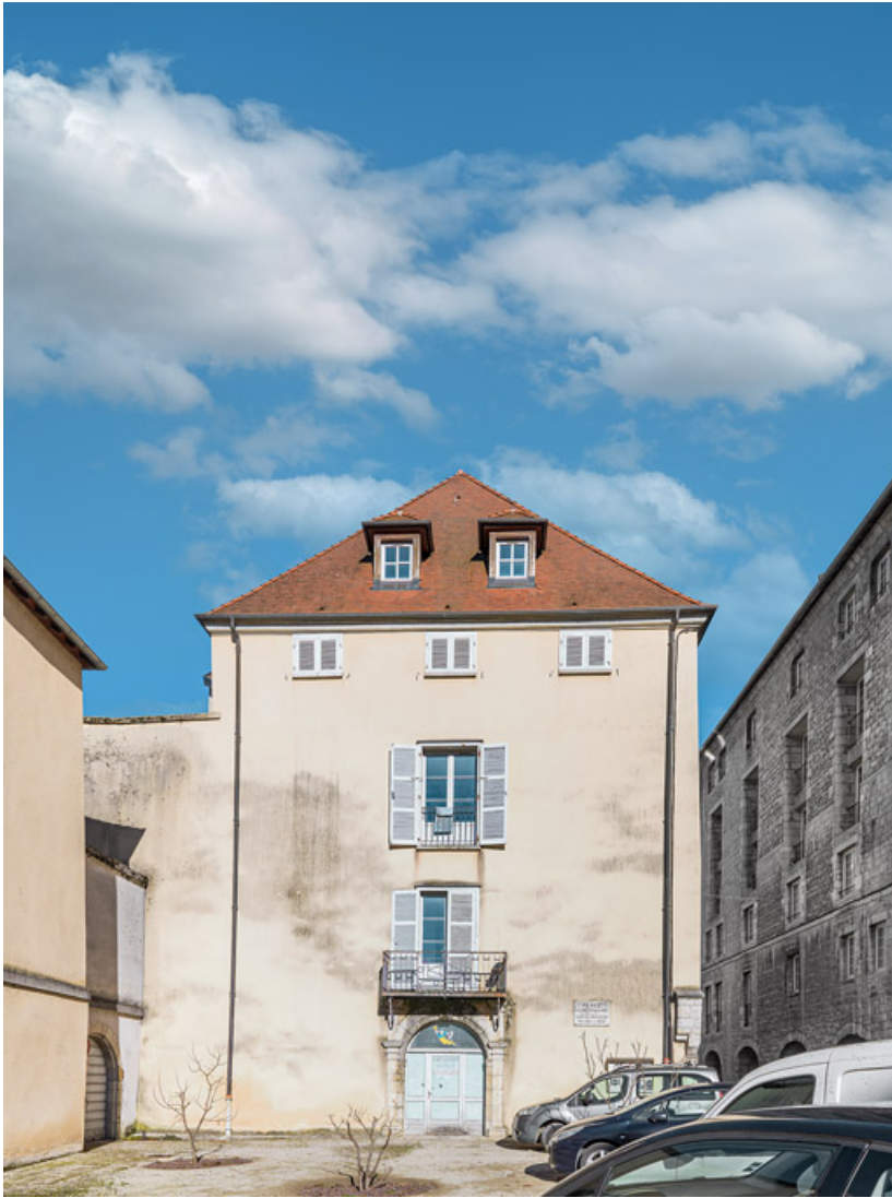
Immeuble sur rue. Façade sud donnant sur la place de la Reconnaissance. 39, Salins-les-Bains, 37 rue de la Liberté
