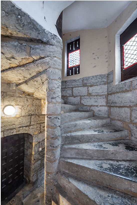
Escalier en vis : accès au premier étage.
