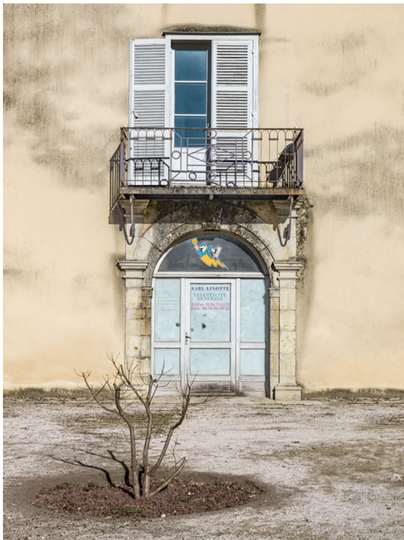
Façade sud de l'immeuble sur rue. Baies réimplantées suite à la démolition des immeubles 27 à 31 rue de la Liberté. 39, Salins-les-Bains, 37 rue de la Liberté
