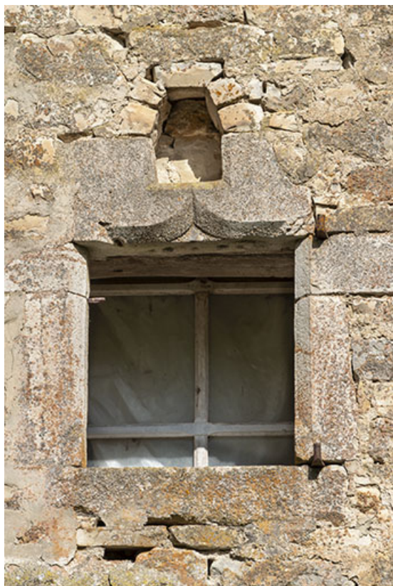
Pignon est. Détail d'un linteau sculpté de l'étable (emploi ?).
