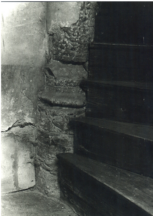
Escalier en vis (jonction entre la maison et l'aile nord du couvent). Base du noyau, 1979. 39, Salins-les-Bains, 79 rue de la République
