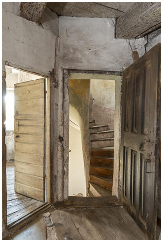
Entrée du couloir depuis la tour polygonale.
