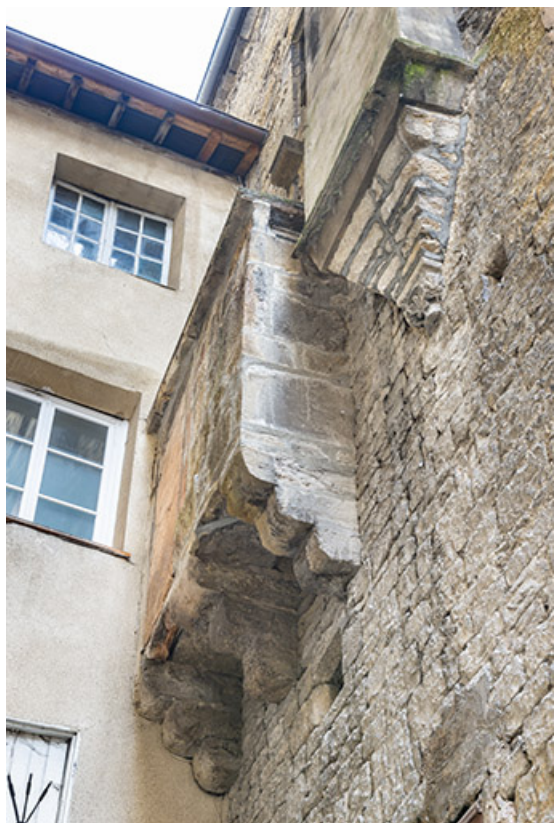
Bretèche et partie en encorbellement sur le mur nord du bâtiment sur rue. 39, Salins-les-Bains, 79 rue de la République
