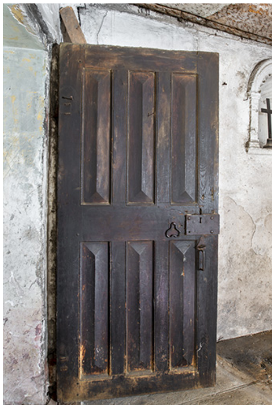
Porte de communication entre la tour polygonale et l'aile nord.
