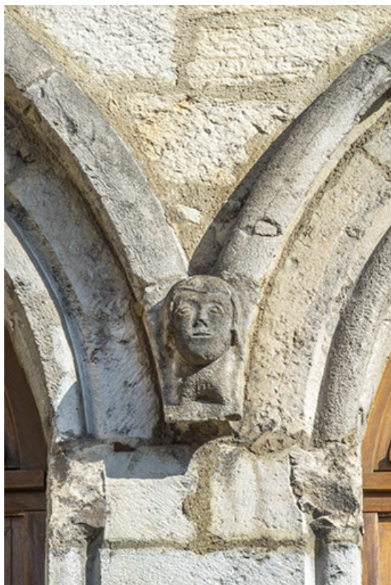
Façade antérieure. Tête sculptée à la retombée des arcs des deux premières baies.
