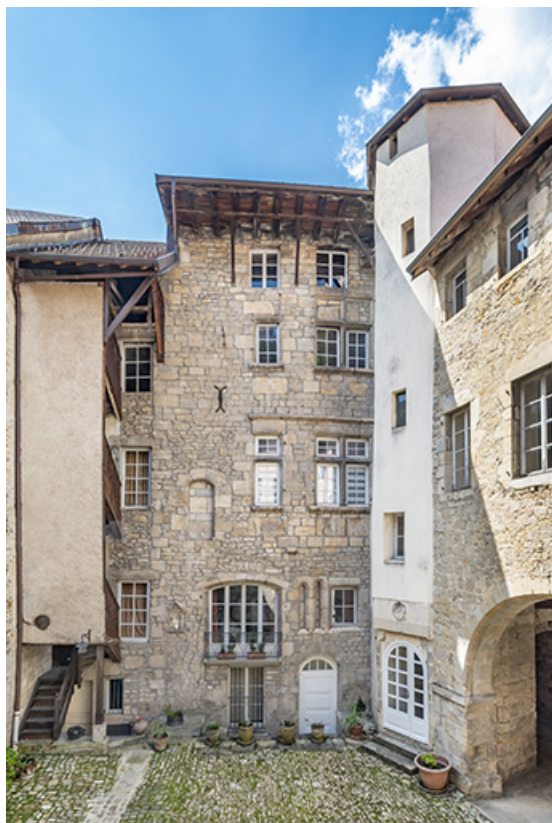
Bâtiment sur rue. Élévation de la façade postérieure, et tour d'escalier polygonale au joignant du bâtiment conventuel nord. 39, Salins-les-Bains, 79 rue de la République
