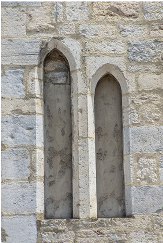
Façade antérieure. Baies étroites du deuxième étage.
