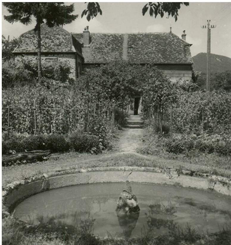
La maison vue depuis le jardin, au sud, fotogr. Georges Chenu, s.d. [milieu 20e siècle]. 39, Salins-les-Bains, lieudit : le Paradis
