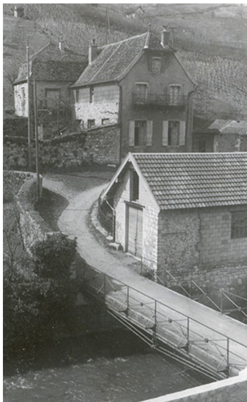
Vue d'ensemble depuis le sud-est, fotogr. Georges Chenu, s.d. [milieu 20e siècle]. 39, Salins-les-Bains, lieudit : le Paradis
