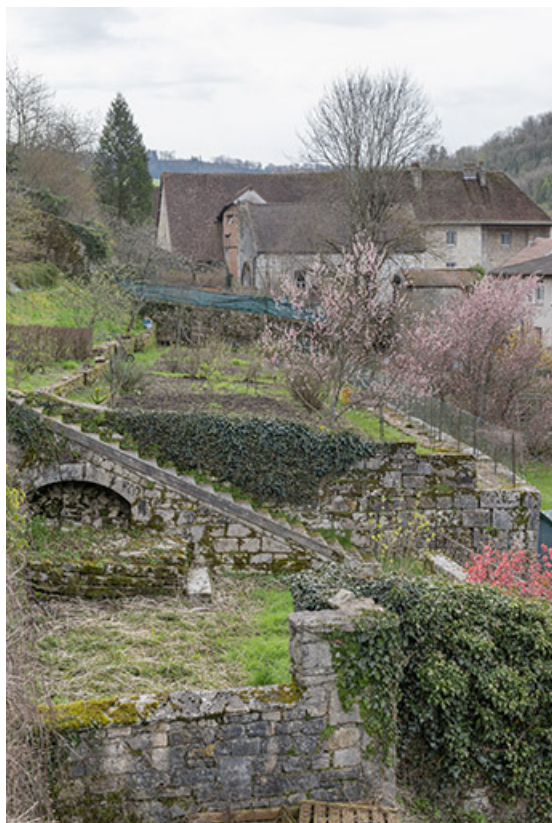
Terrasses en terre-plein des hôtels n°88 et 86 de la rue de la Liberté. 39, Salins-les-Bains, 88 rue de la Liberté
