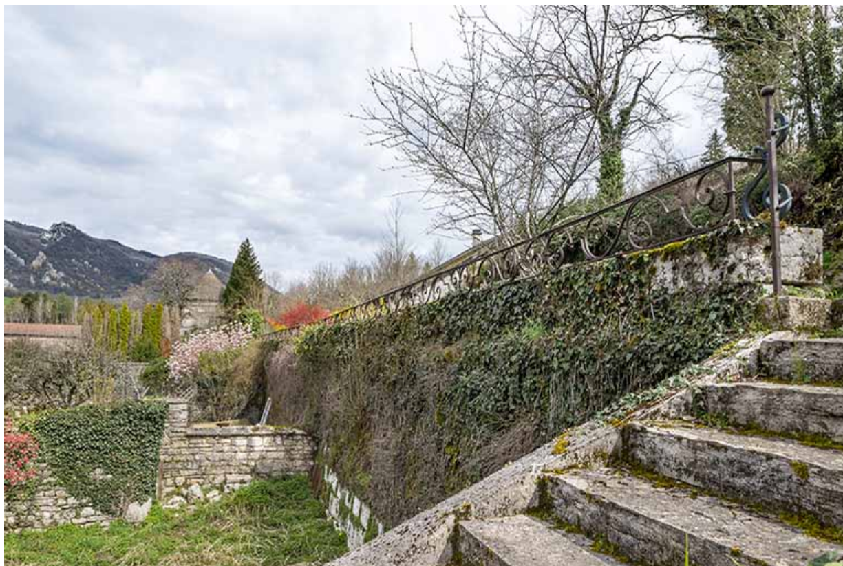
Terrasses supérieures, depuis le sud.
