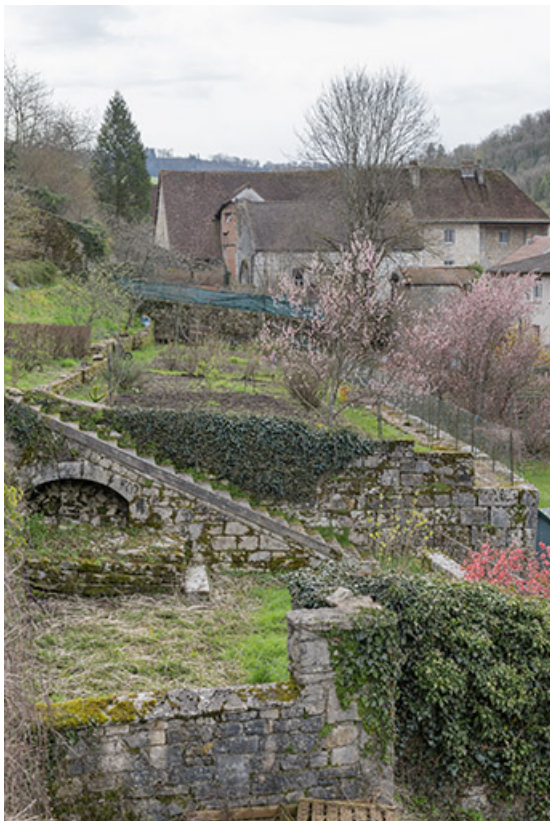
Terrasses en terre-plein des hôtels n°88 et 86 de la rue de la Liberté. 39, Salins-les-Bains, 88 rue de la Liberté
