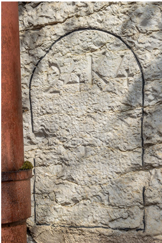
Borne gravée (24K4) au nord de la façade.
