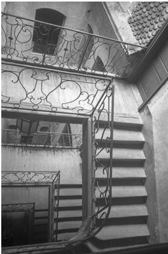
Vue plongeante sur la cage d'escalier, s.d. [vers 1960].
