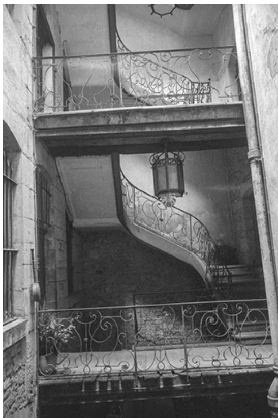
La cage d'escalier, s.d. [vers 1960].
