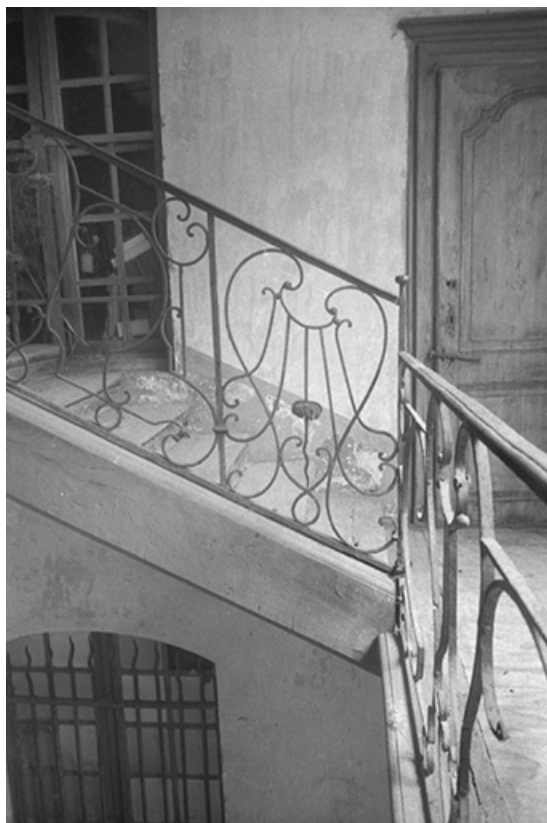
Cage d'escalier. Ferronnerie du garde-corps, s.d. [vers 1960].
