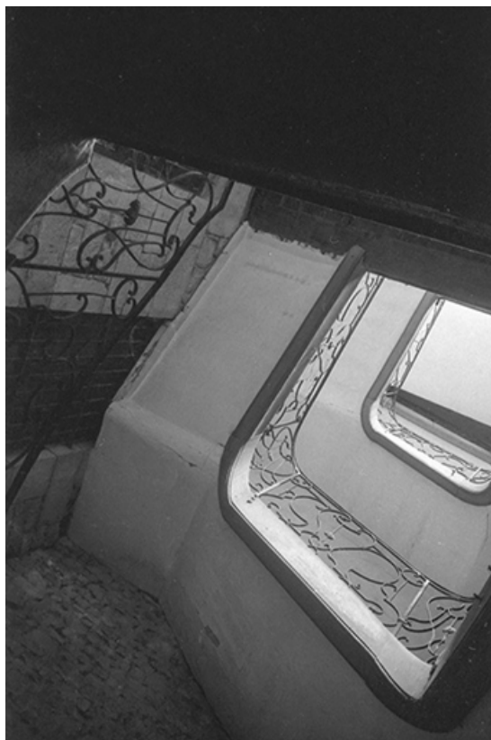
Vue en contre-plongée de la cage d'escalier, s.d. [vers 1960].
