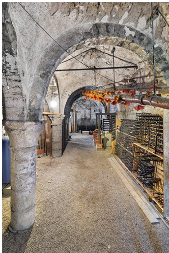
Vue d'ensemble de la cave, depuis l'ouest.
