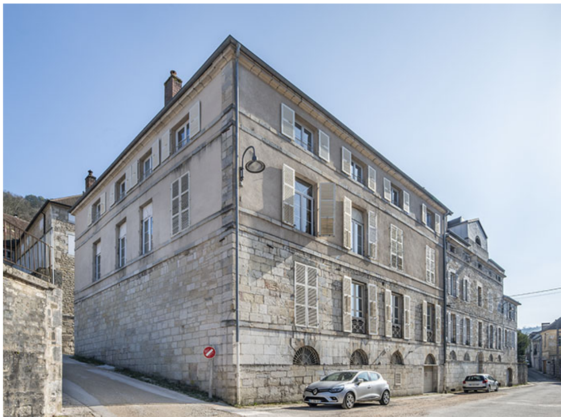
Vue de trois quarts, depuis le nord-ouest.
