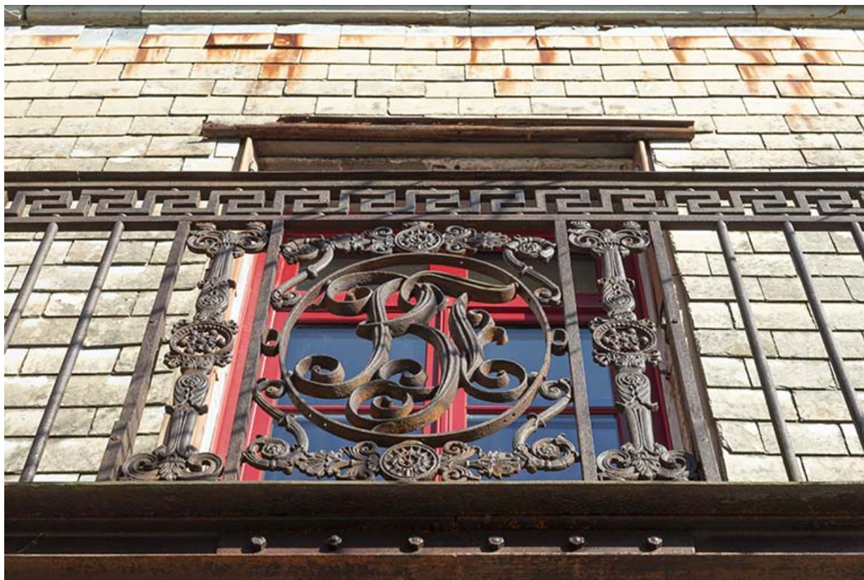
Vue en contre-plongée du garde-corps du balcon.
