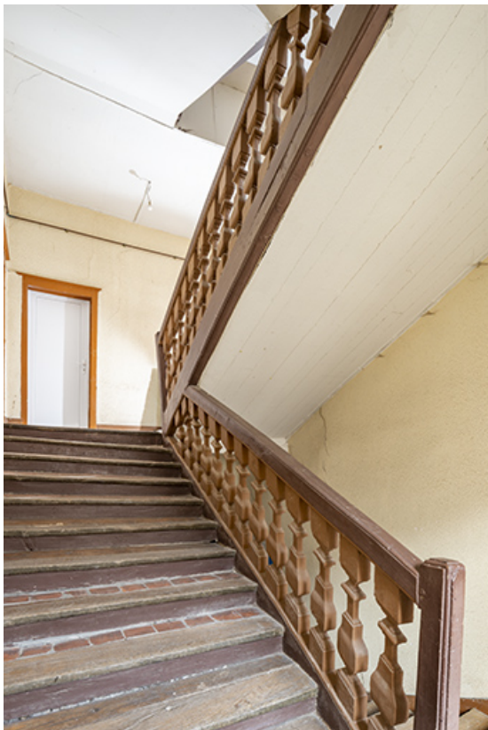
Escalier (n°3). Vue depuis le premier étage.
