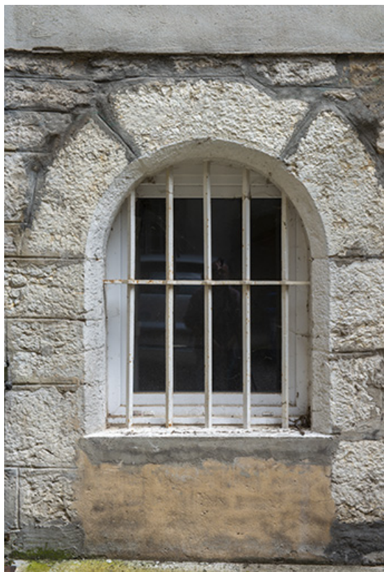
Façade est. Baie en plein-cintre du rez-de-chaussée.
