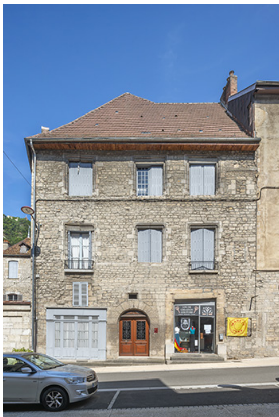
Bâtiment sud. Vue de face.
