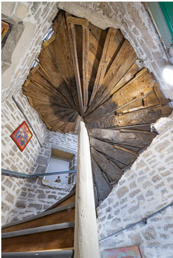
Escalier en vis (entrée n°1 cour des Halles). Vue en contre-plongée.
