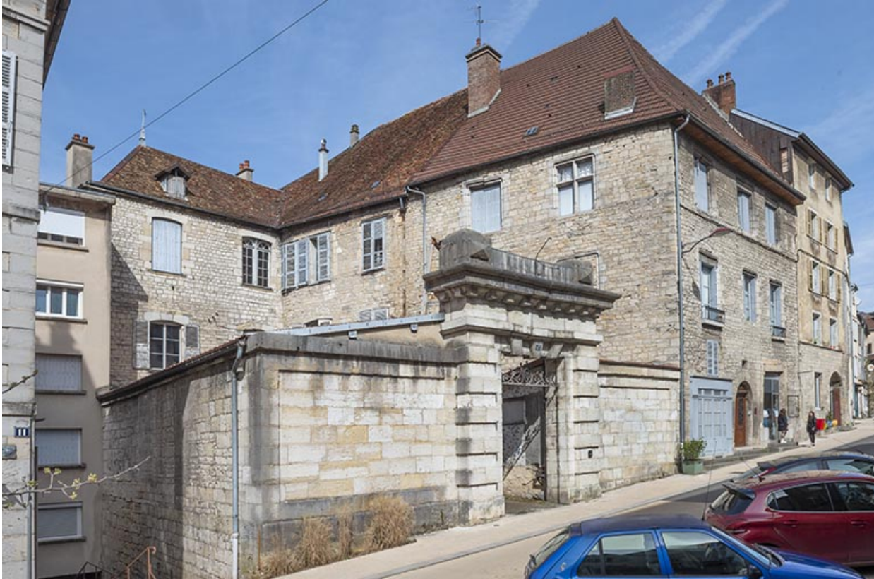
Vue d'ensemble de trois quarts gauche (l'hôtel est en fond de cour). 39, Salins-les-Bains, 13 rue de la Liberté
