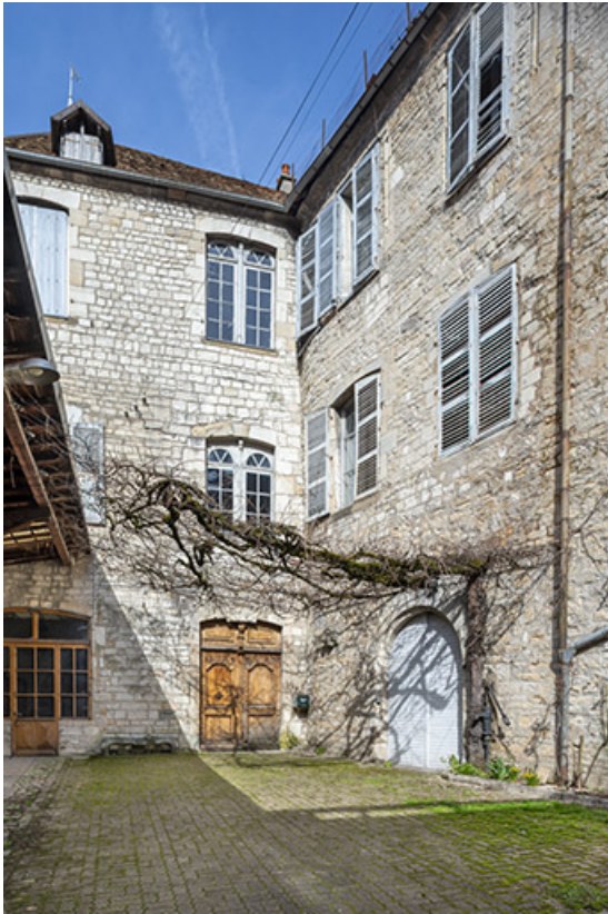
Façades est et sud depuis la cour.
