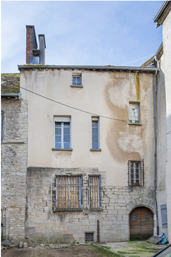
Aile nord (vue depuis la cour des halles).
