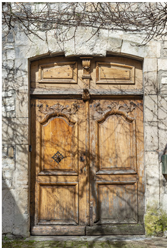
Porte droite sur cour (mur est).
