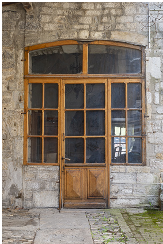
Porte gauche sur cour (mur est).
