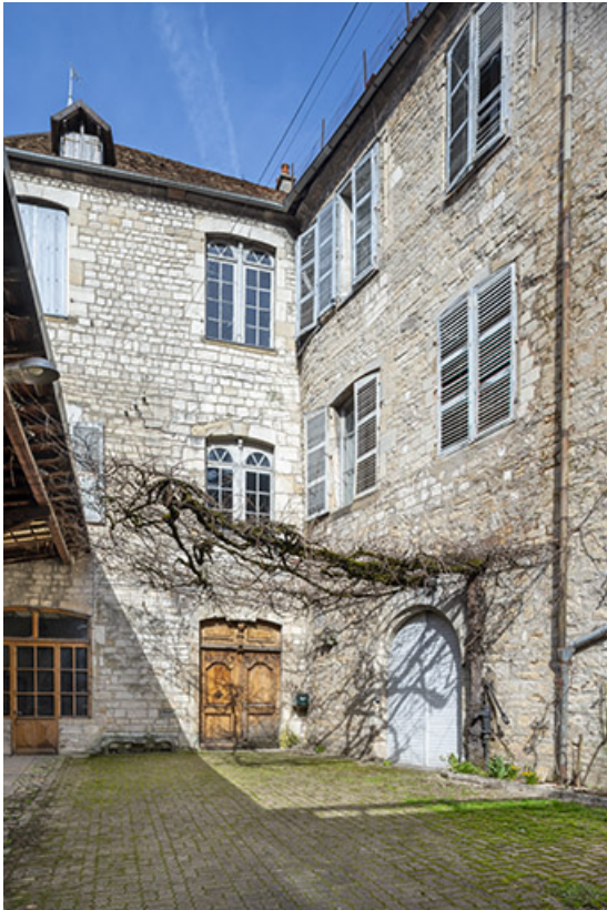
Façades est et sud depuis la cour.
