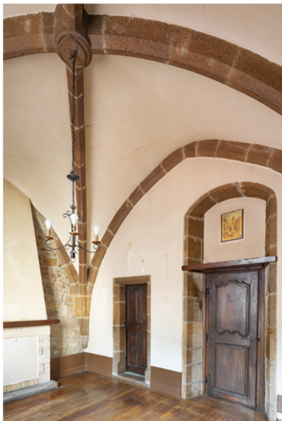
Voûtement de la pièce au premier étage.
