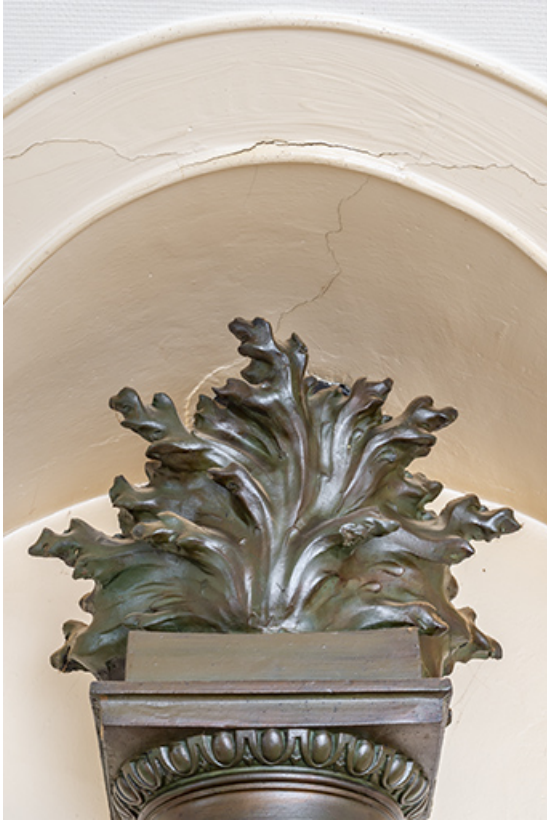
Cheminée. Couronnement du conduit d'évacuation (grès flammé).
