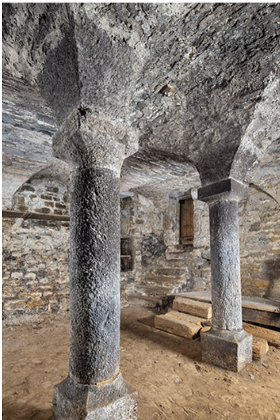
Vue de la cave depuis le sud.
