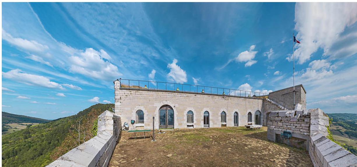
Vue depuis l'échauguette de la façade postérieure.
