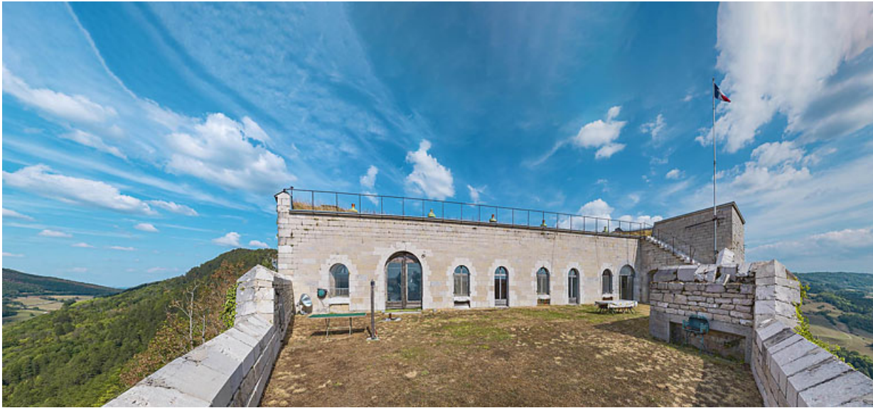
Vue depuis l'échauguette de la façade postérieure.
