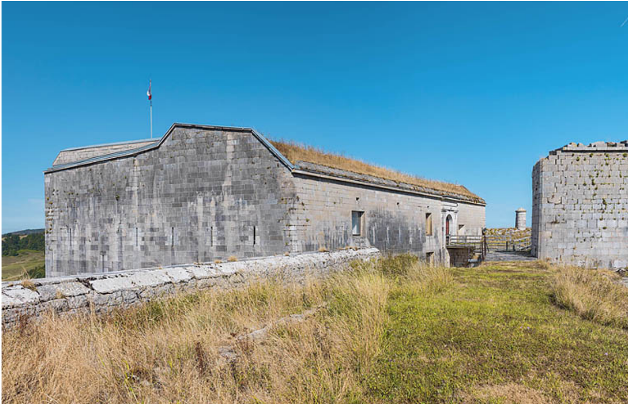
Vue depuis le toit du bâtiment casematé à usage de casernes et magasins. 39, Salins-les-Bains chemin touillon, lieudit : Belin
