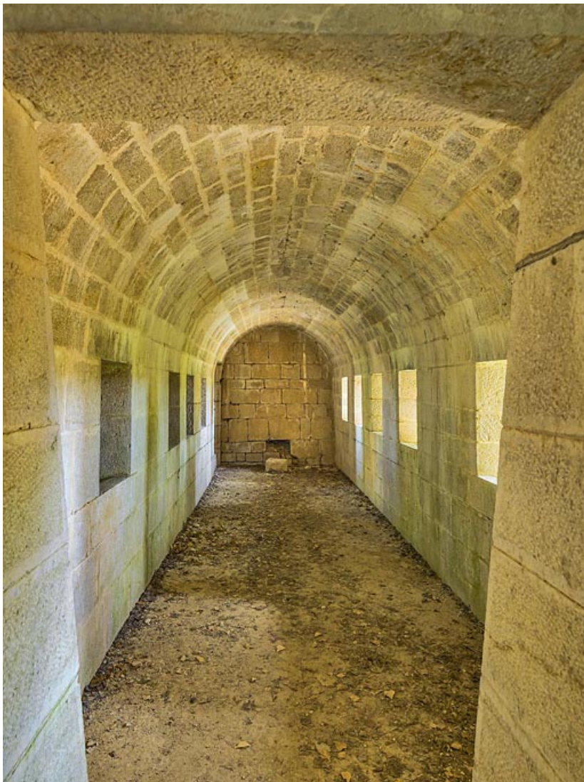
Caponnière flanquant l'intérieur du fossé.
