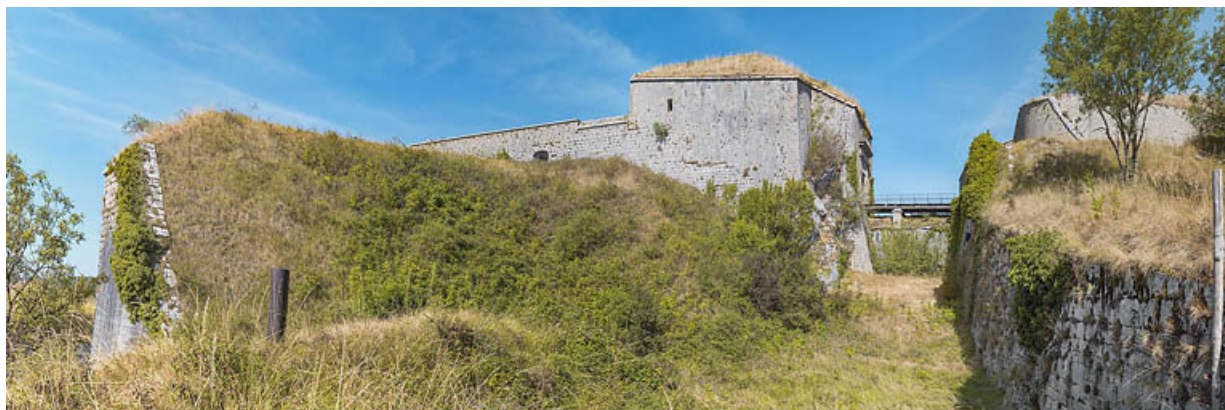
De gauche à droite : aile de l'ouvrage à cornes, le cavalier, le fossé, la contrescarpe et le réduit protégeant l'entrée du fort. 39, Salins-les-Bains chemin Touillon, lieudit : Belin
