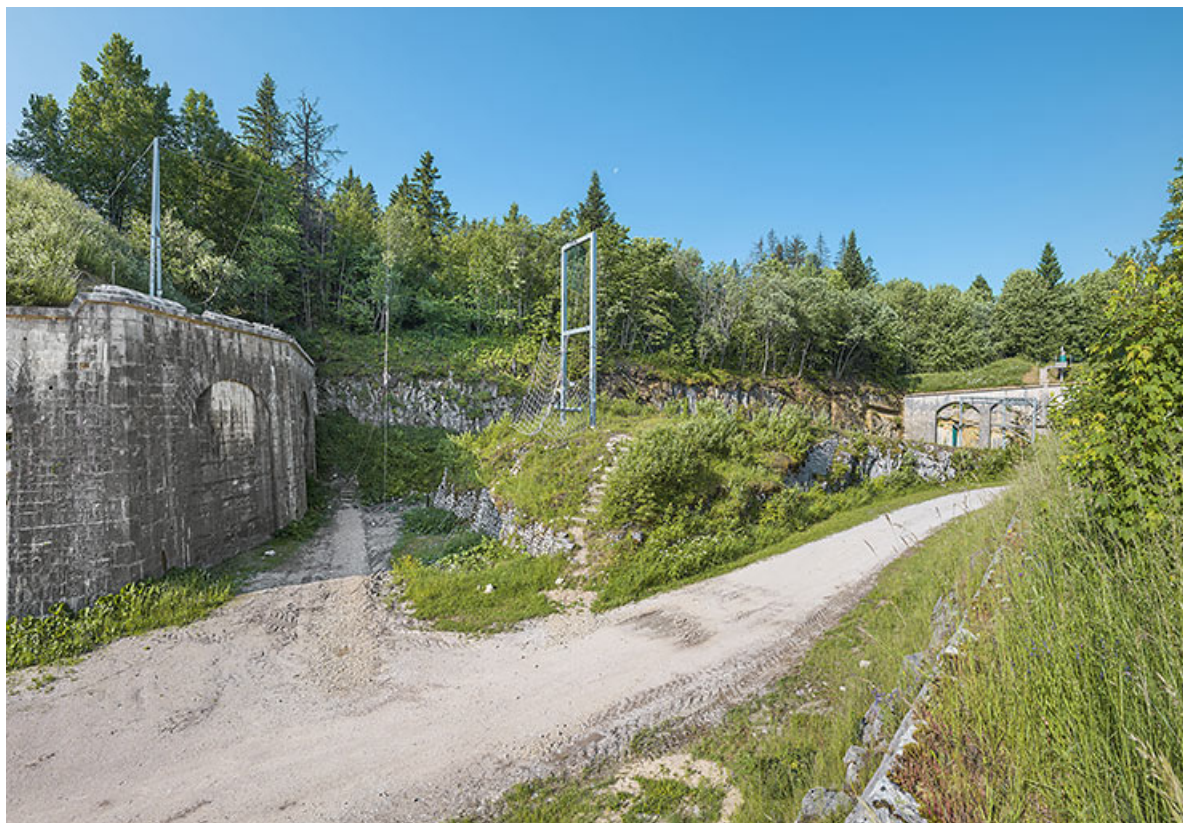
Fort des Rousses : tenaille défendant l'accès à la porte de France. 39, Les Rousses
