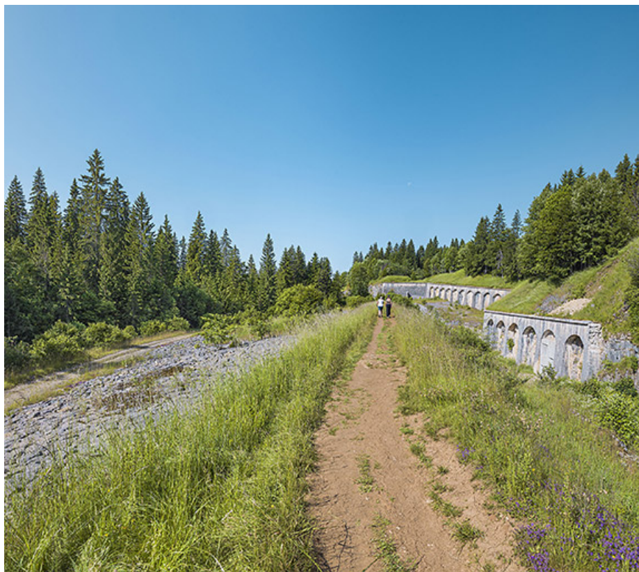
Fort des Rousses : front nord-ouest (de gauche à droite : le glacis, le fossé et le mur d'escarpe). 39, Les Rousses
