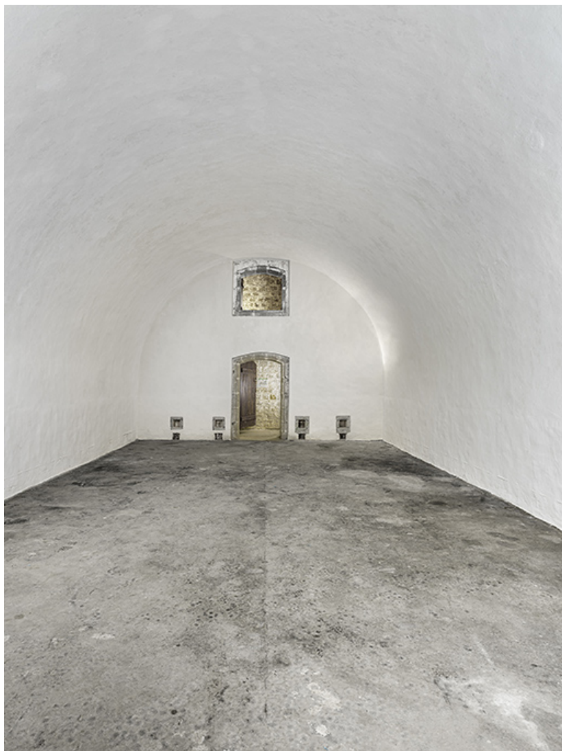
Chambre de stockage d'un des magasins à poudre du fort.
