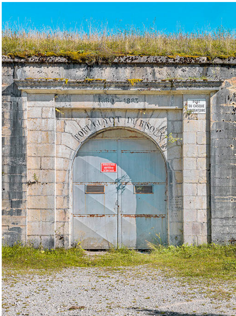
Porte du fort du Risoux.
