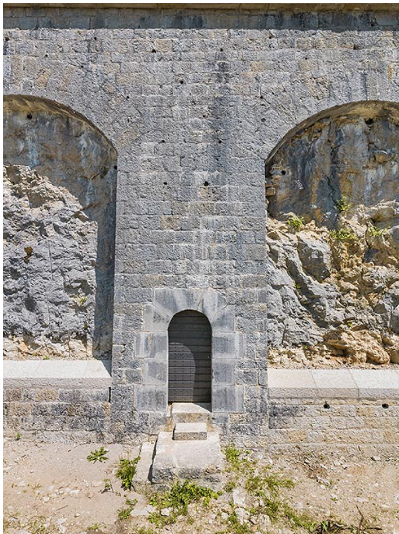
Fort des Rousses : poterne située au front sud-ouest. 39, Les Rousses
