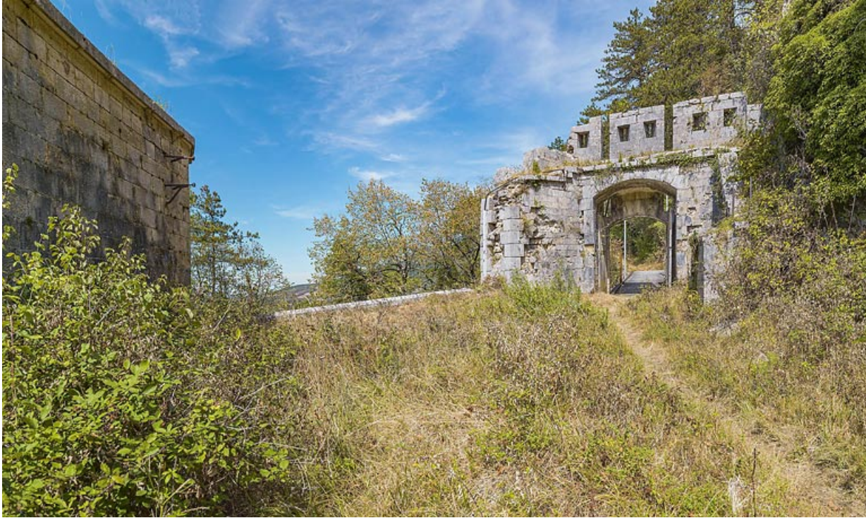
Vue depuis la cour en direction de la porte d'entrée.
