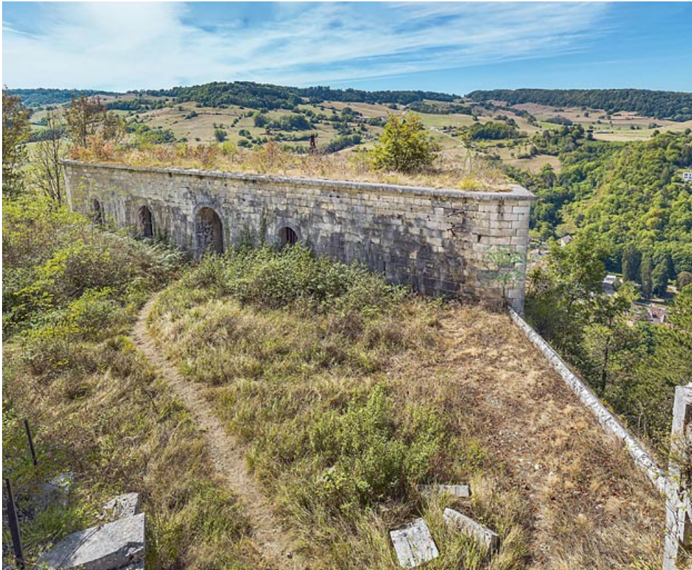
Le bâtiment casematé : façade postérieure.
