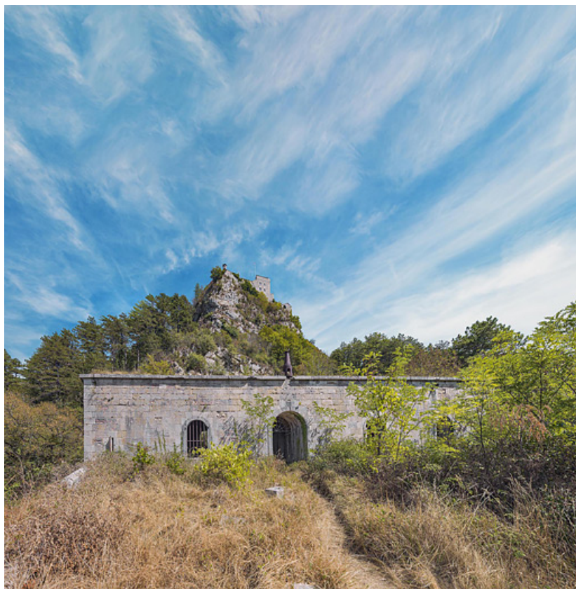
Le bâtiment casematé : la façade antérieure.
