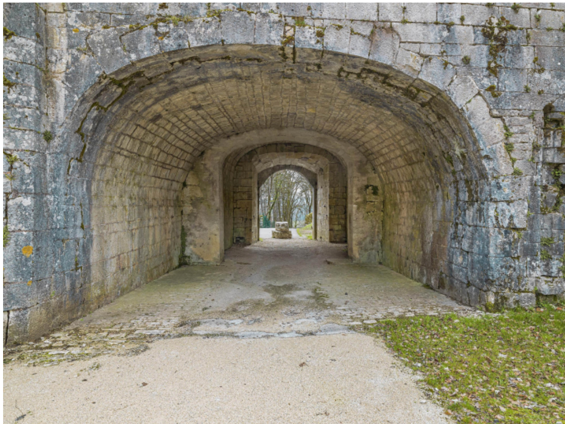
Le passage, vue depuis la cour intérieure.
