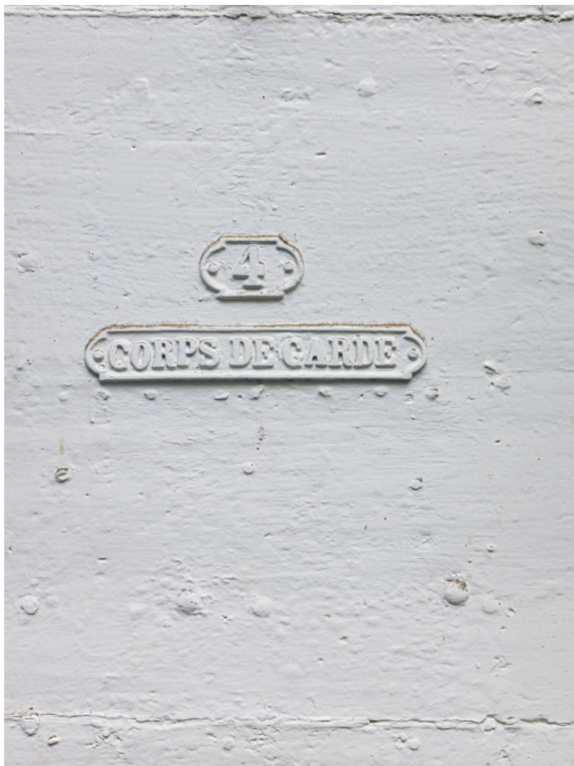
Le passage voûté : porte d'entrée du corps de garde (détail de l'inscription). 39, Salins-les-Bains chemin communal du fort Saint-André, lieudit : Fort Saint-André
