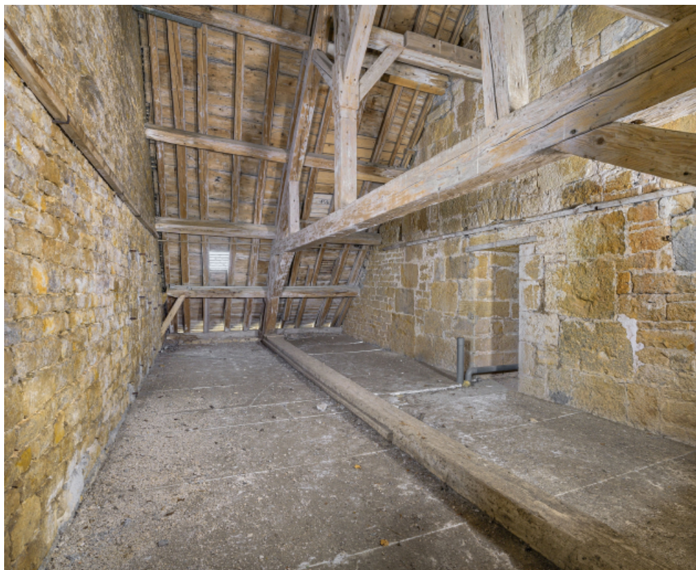
Caserne U, grenier : vue générale d'une ferme composant la charpente.
