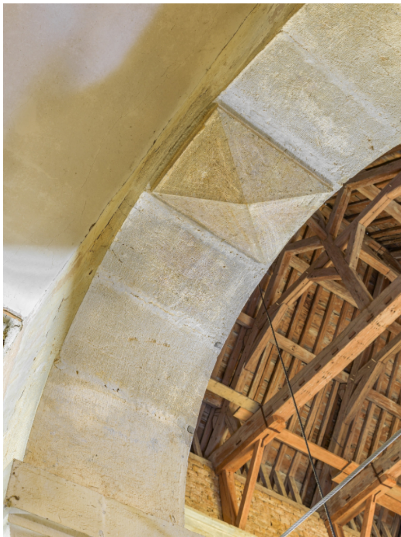
Clé de voûte de l'arcade centrale de la tribune.
