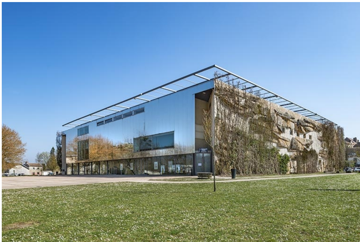
Salle de spectacle la Commanderie : vue d'ensemble, de trois quarts droite. 39, Dole
