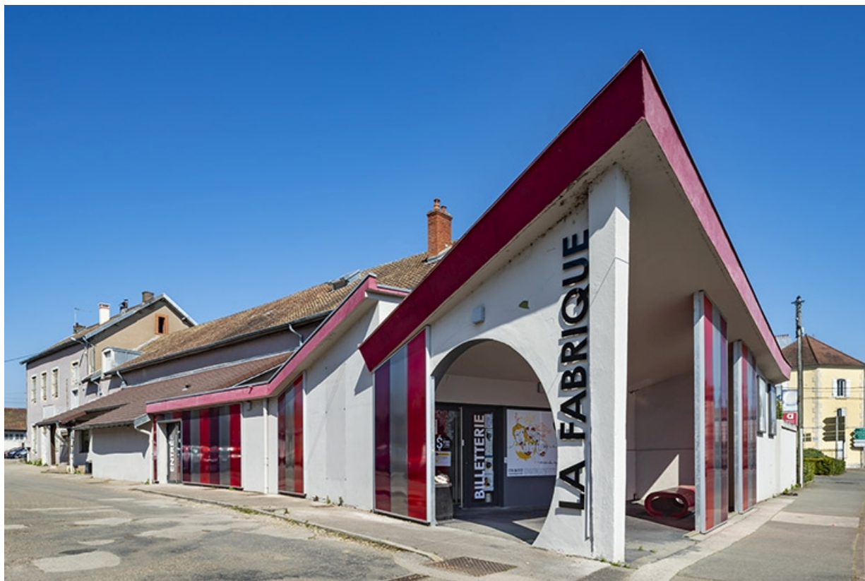
Cinéma et salle de spectacle la Fabrique : vue d'ensemble. 39, Dole
