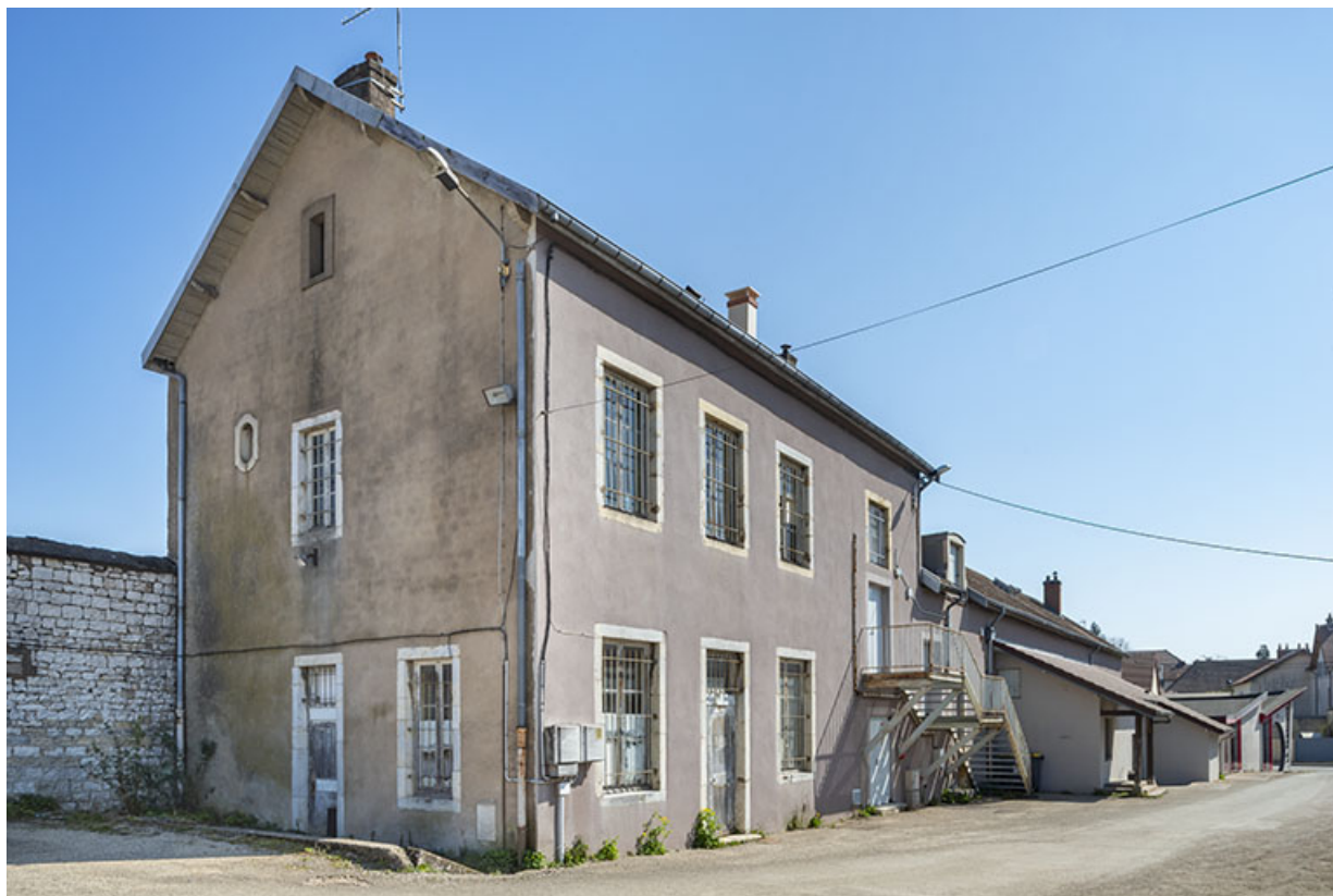
Façade latérale gauche, de trois quarts gauche.
