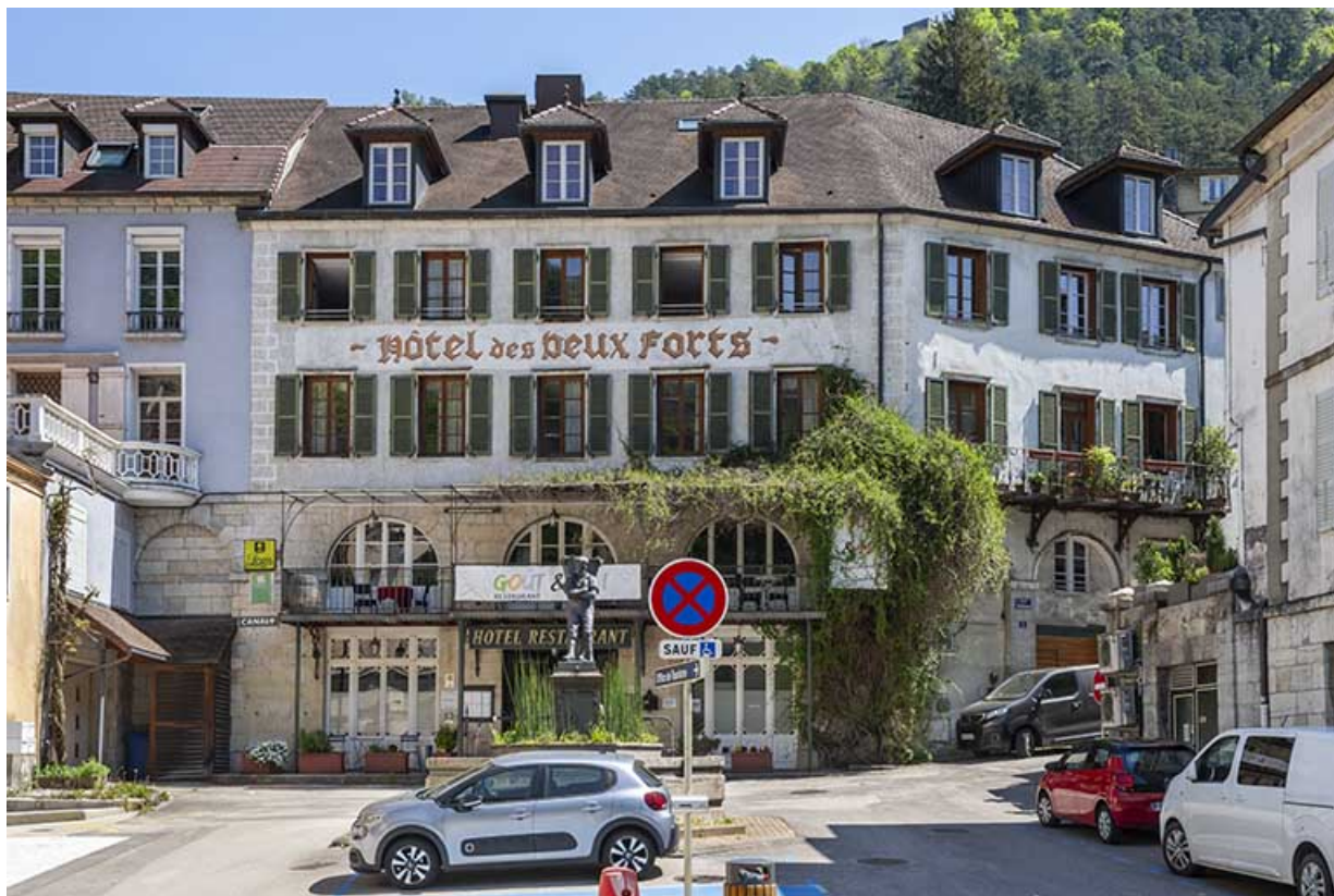
Façade sur la place du Vigneron, vue de face. 39, Salins-les-Bains, 5 place du Vigneron
