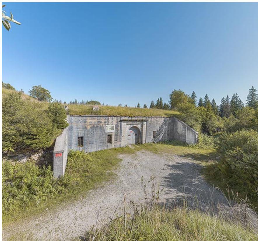
Bâtiment d'entrée, vue de trois quarts gauche.
