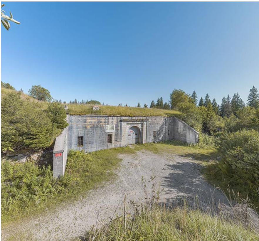
Bâtiment d'entrée, vue de trois quarts gauche.
