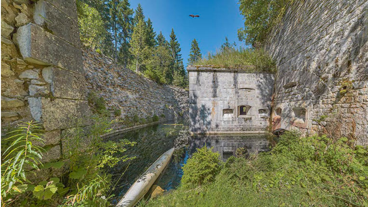
La double caponnière (front de gorge), vue depuis le fossé.
