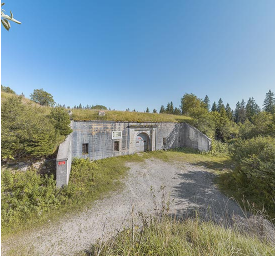
Bâtiment d'entrée, vue de trois quarts gauche.
