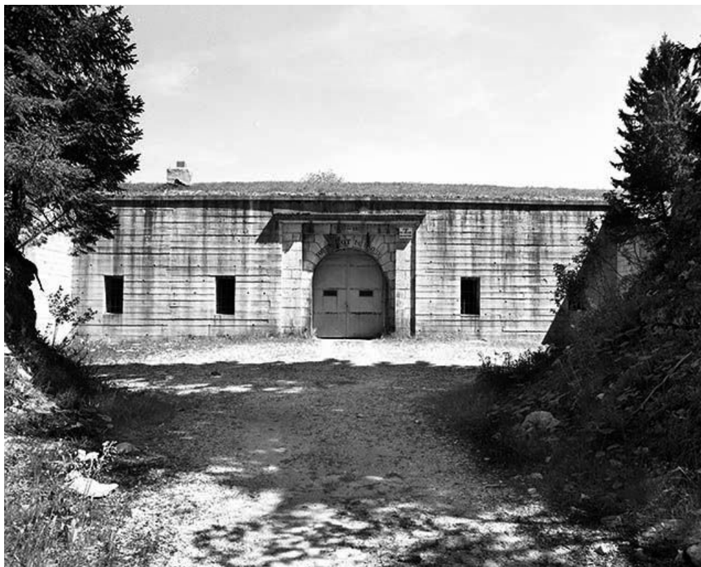
Façade antérieure, vue éloignée.
