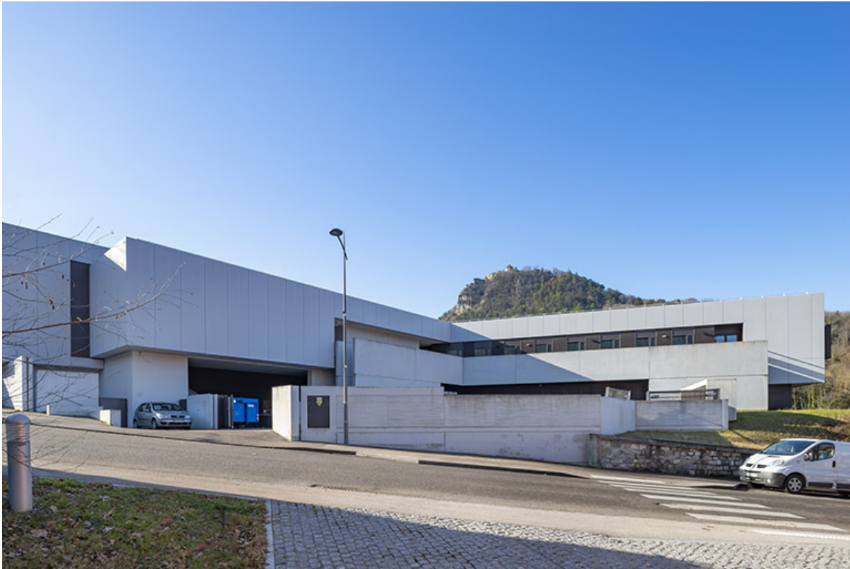
Façade postérieure, entrée des équipements techniques sur la rampe Barbarine. 39, Salins-les-Bains place Barbarine
