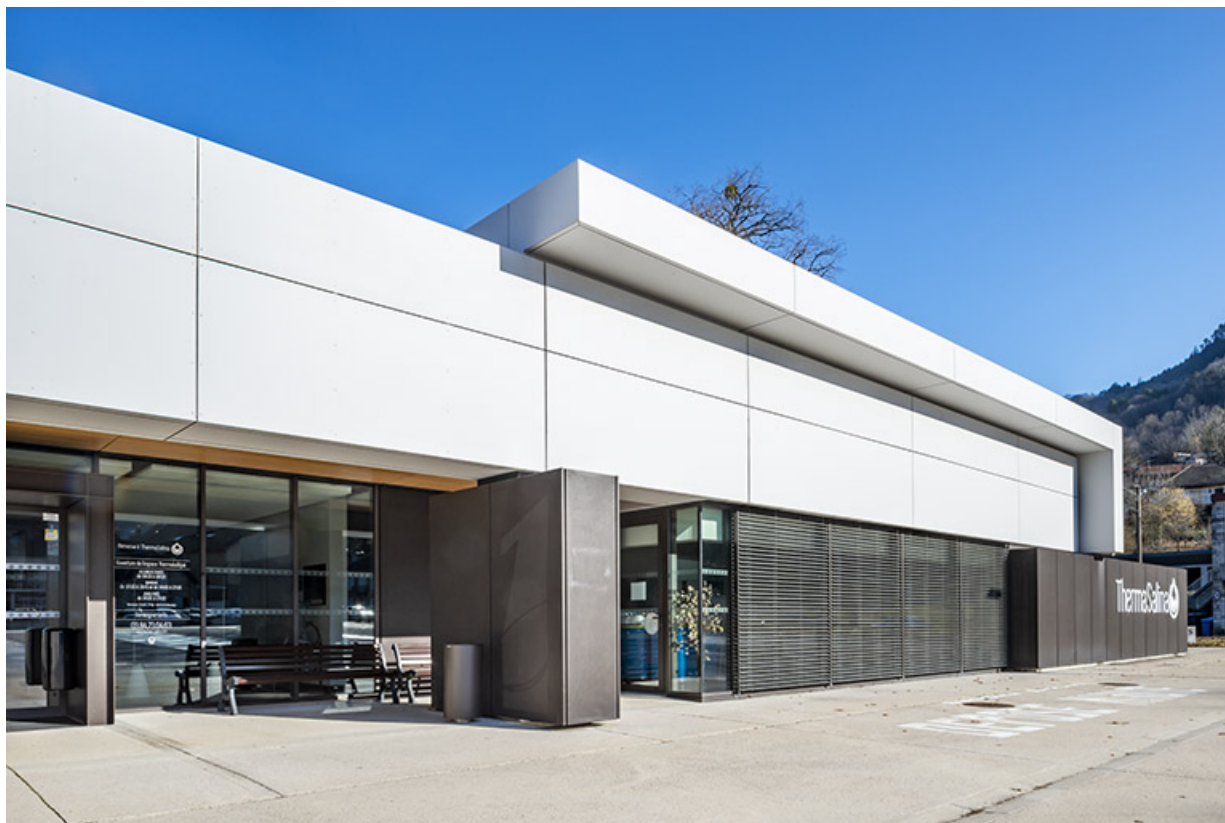
Façade sud, accès principal des curistes, depuis l'ouest.
