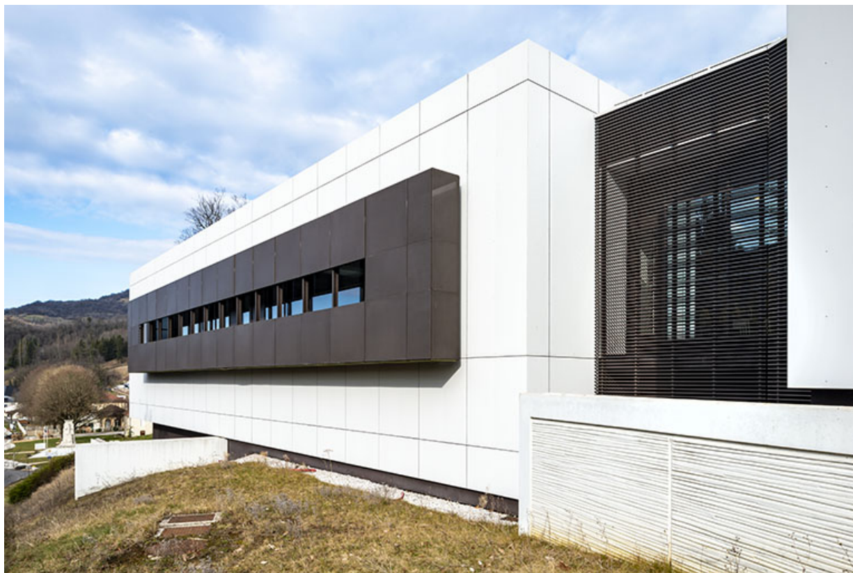
Vue depuis le sud-ouest.
