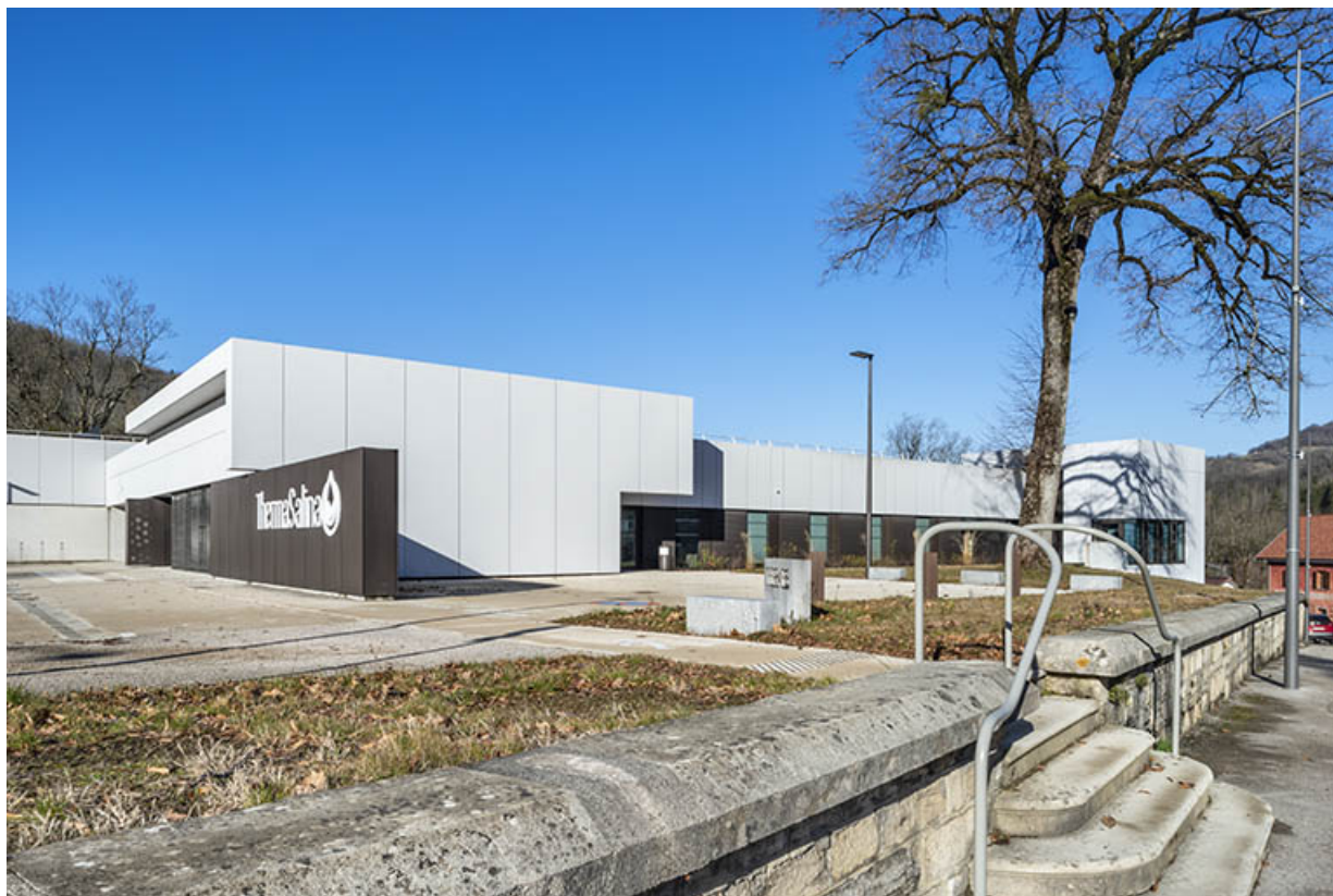
Vue depuis le sud-est.
