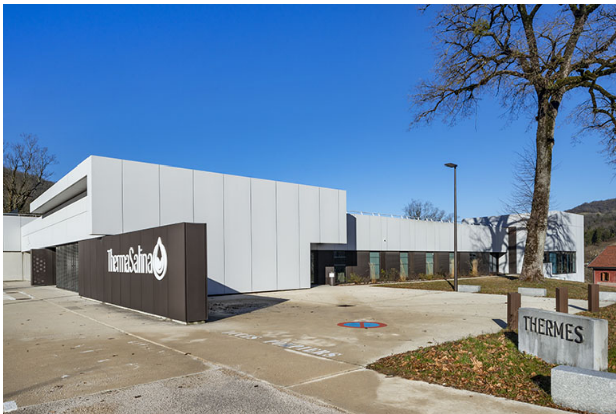
Vue depuis le sud-est.
