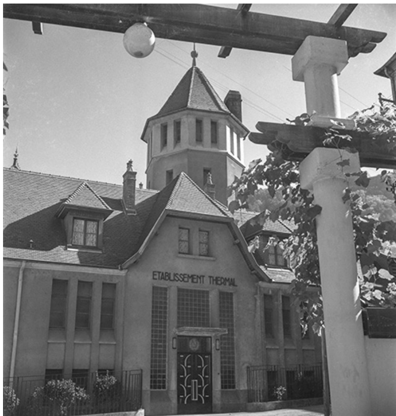
Entrée de l'établissement, s.d. [vers 1960].
