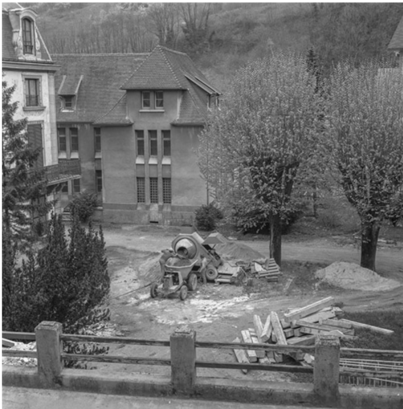
Façade postérieure, s.d. [vers 1960].
