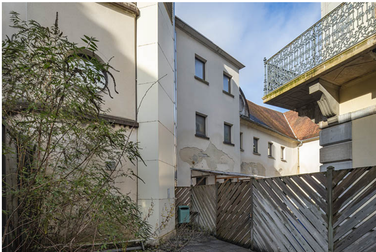
Façade orientale du corps de bâtiment principal, vue depuis le sud.
