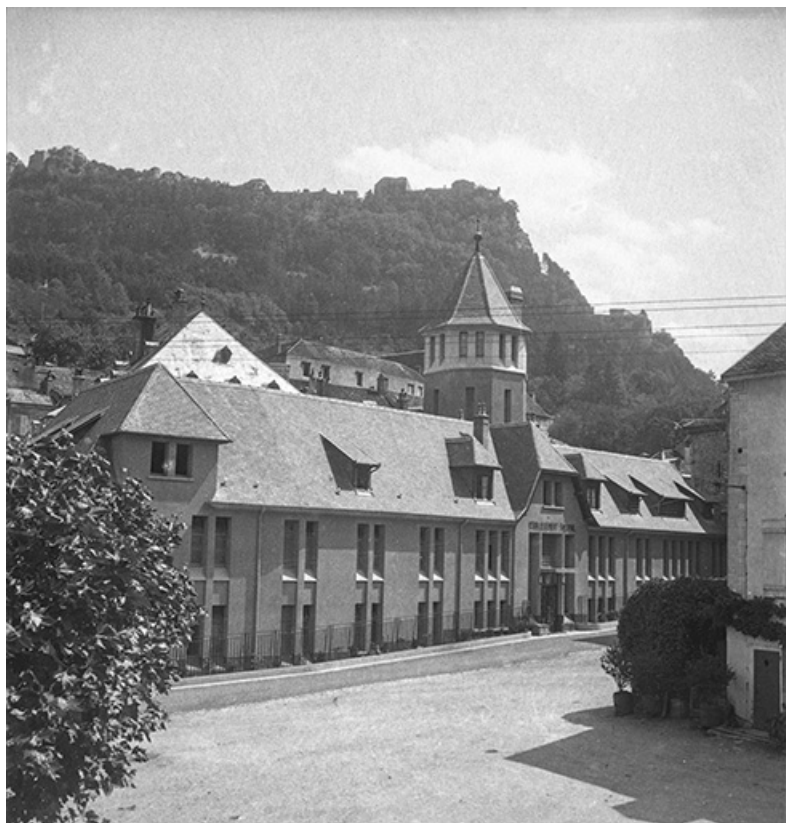
Façade antérieure vue de trois quarts gauche, s.d. [vers 1960].
