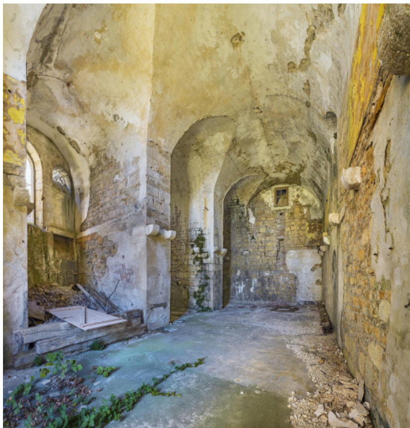
Vue intérieure du bâtiment casematé.
