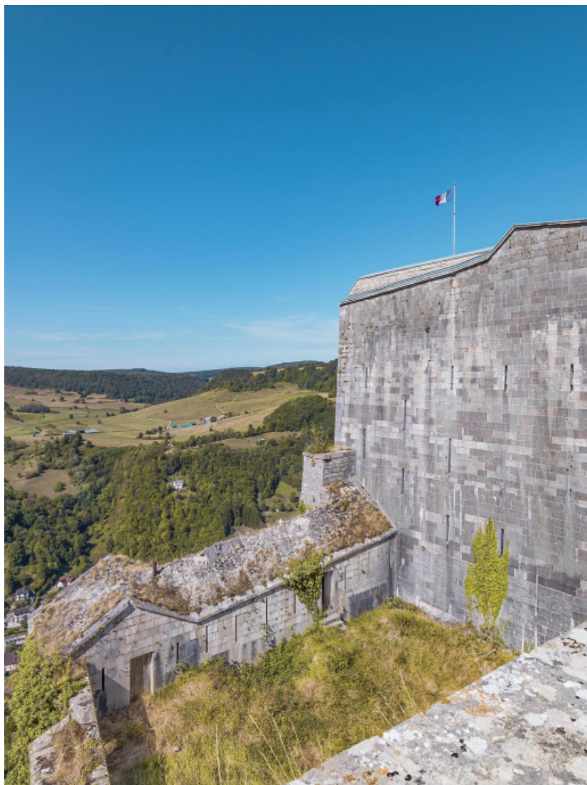
Mur pignon sud du réduit intérieur et plateforme du bastion carré.
