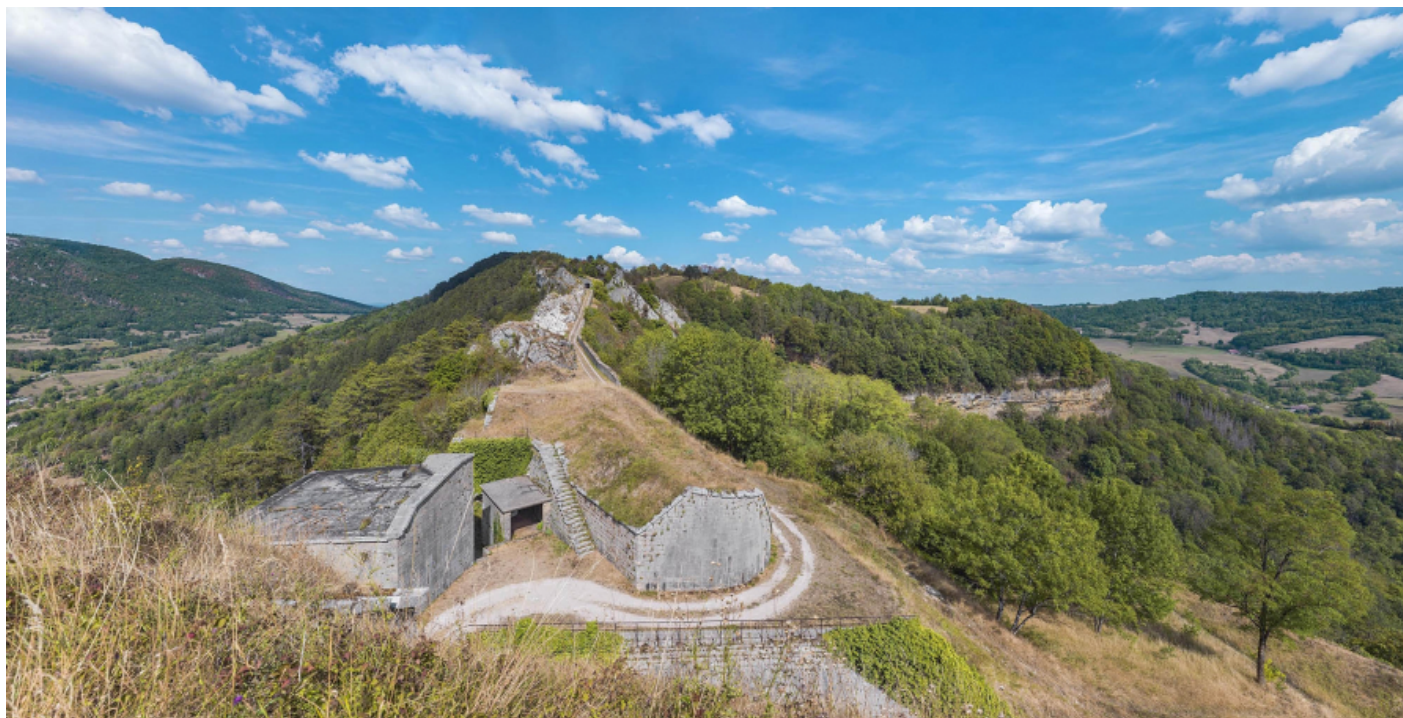
Vue vers la redoute de Greilimbach depuis le toit du cavalier.
