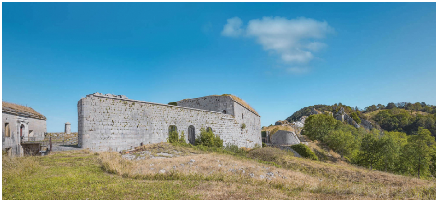
Le rempart en retour d'équerre du cavalier depuis le couvert végétal du bâtiment casematé servant de caserne et de magasins. 39, Salins-les-Bains chemin Touillon, lieudit : Belin
