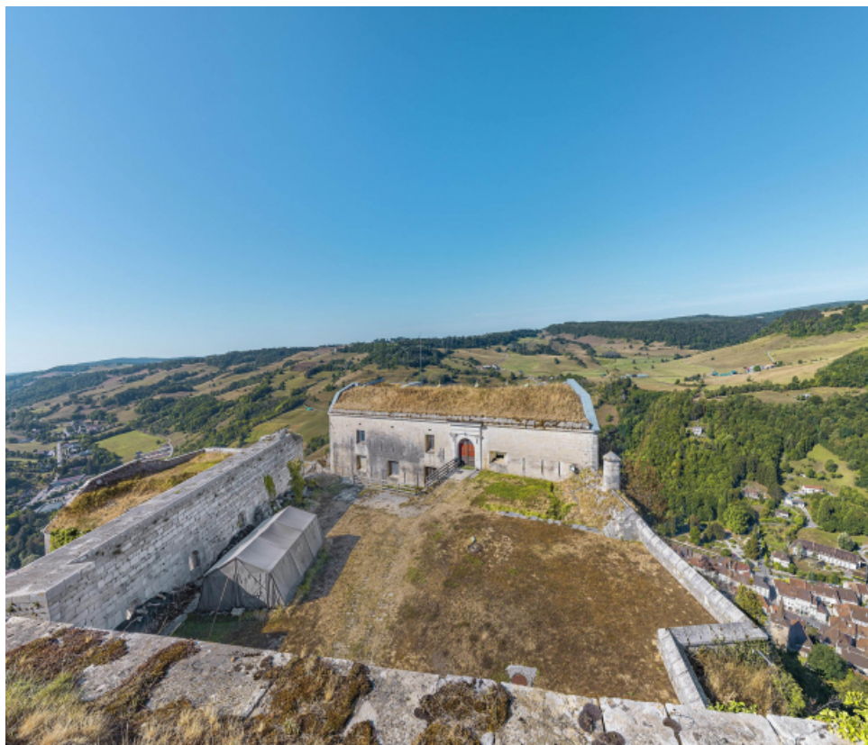
Le réduit depuis le toit du cavalier : façade antérieure.
